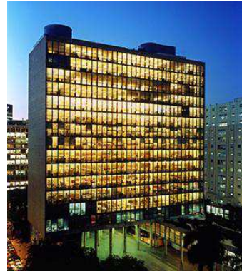
Foto 08 - Prédio do MES
