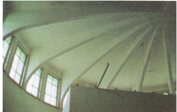
Foto 02 - Interior da Estação. Detalhe das nervuras do teto
