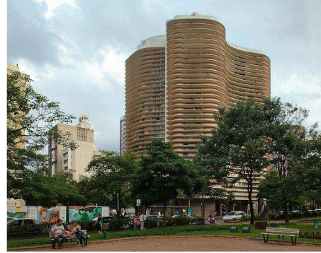
Foto 45 - Edifício Niemeyer, MG
