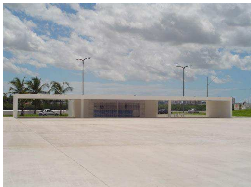
Foto 75 - Vista frontal do bar/ sanitários
