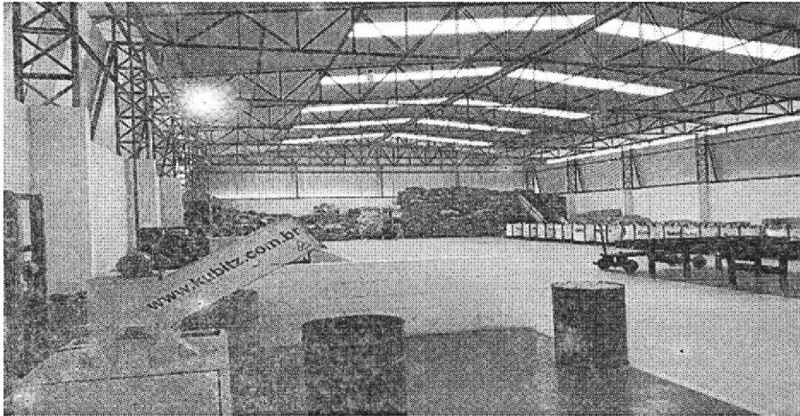
Figura 11 - Usina de Beneficiamento de Resíduos de Construção Civil
