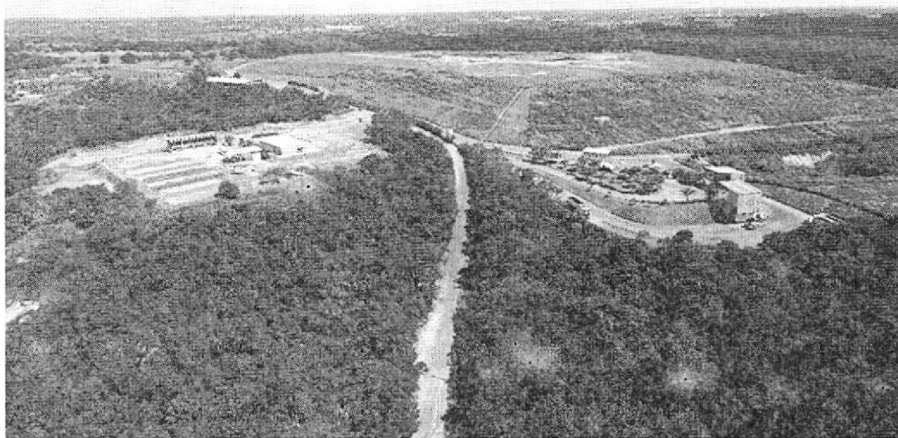
Figura 4 - Vista Aérea do Centro Ambiental Ribeira
