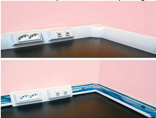
Foto 12 - Rodapé em PVC com passagem de fiação
