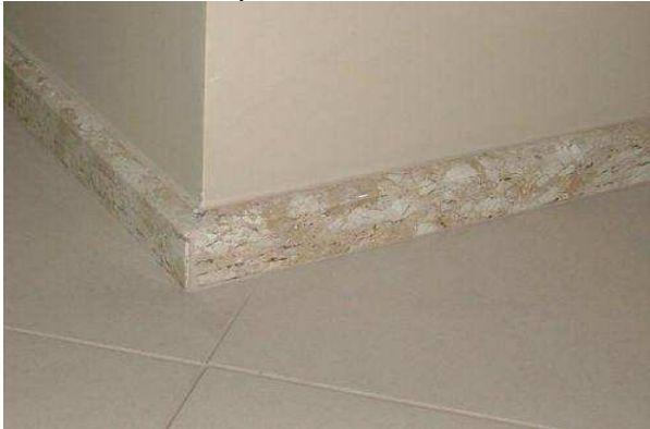
Foto 11 - Rodapé em mármore
