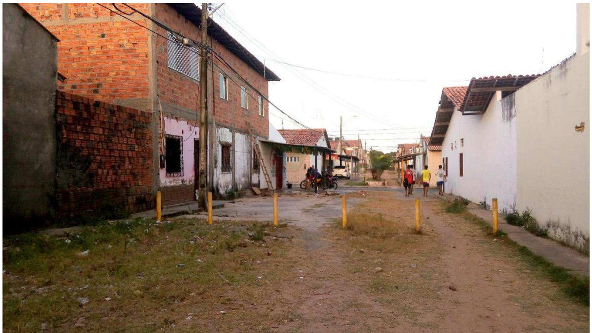
**DESCRIÇÃO:** Passeio existente irregular, sem dimensões adequadas (conforme o item 6.12.3 da NBR 9050), sendo este inexistente do lado esquerdo da via.
