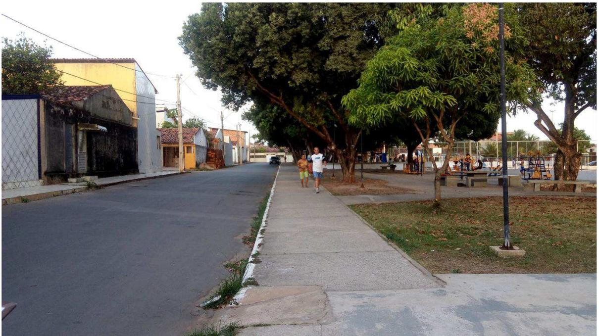
**DESCRIÇÃO:** Passeio existente irregular, podendo prejudicar a circulação segura. Rampa de acesso dimensionada inadequadamente (contradizendo o item 6.12.7.3 da NBR 9050). Ausência de sinalização tátil direcional e de alerta (conforme o item 5.4.6 da NBR 9050).
