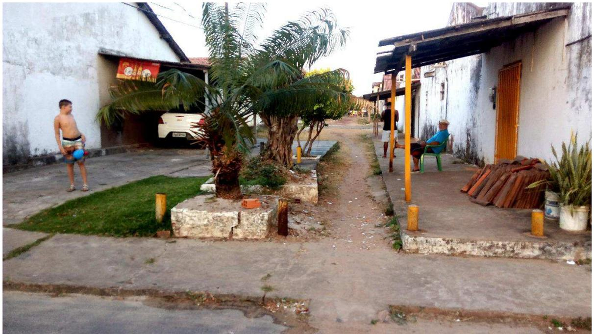
**DESCRIÇÃO:** Passeio existente irregular, sem dimensões adequadas (conforme o item 6.12.3 da NBR 9050). Vegetação atuando como barreira física, impedindo a circulação e a visibilidade do pedestre.
