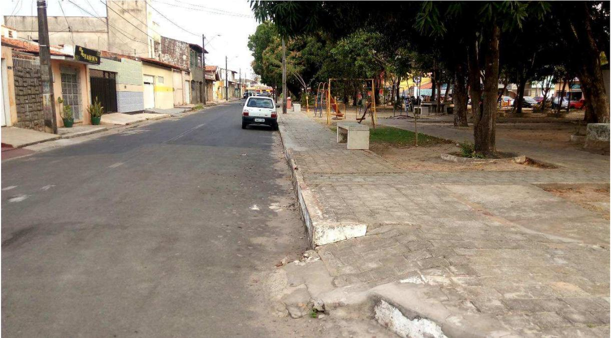
**DESCRIÇÃO:** Pavimentação irregular. Rampa de acesso com inclinação e formato inadequado (contradizendo o item 6.12.7.3 da NBR 9050). Ausência de sinalização tátil direcional e de alerta (conforme o item 5.4.6 da NBR 9050).
