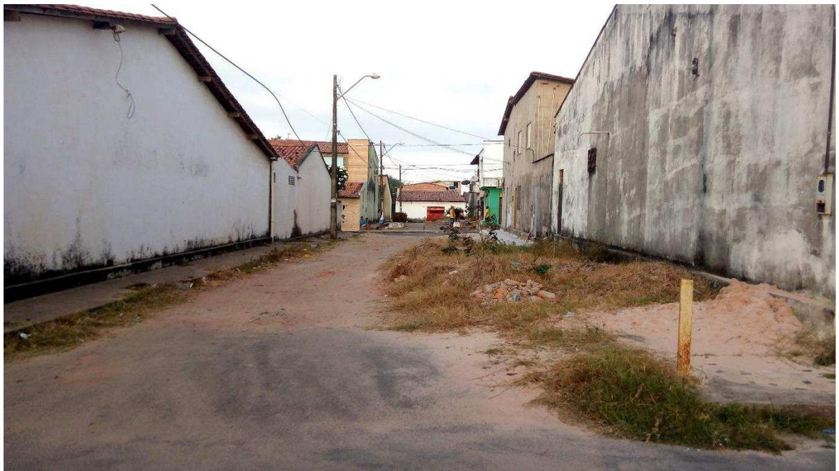
**DESCRIÇÃO:** Ausência de passeio do lado direito da via, devido ao acúmulo de vegetação e lixo, o que induz o pedestre a caminhar pela rua. Inexistência de rampas de acesso no passeio do lado esquerdo da via (conforme o item 6.12.7.3 da NBR 9050).
