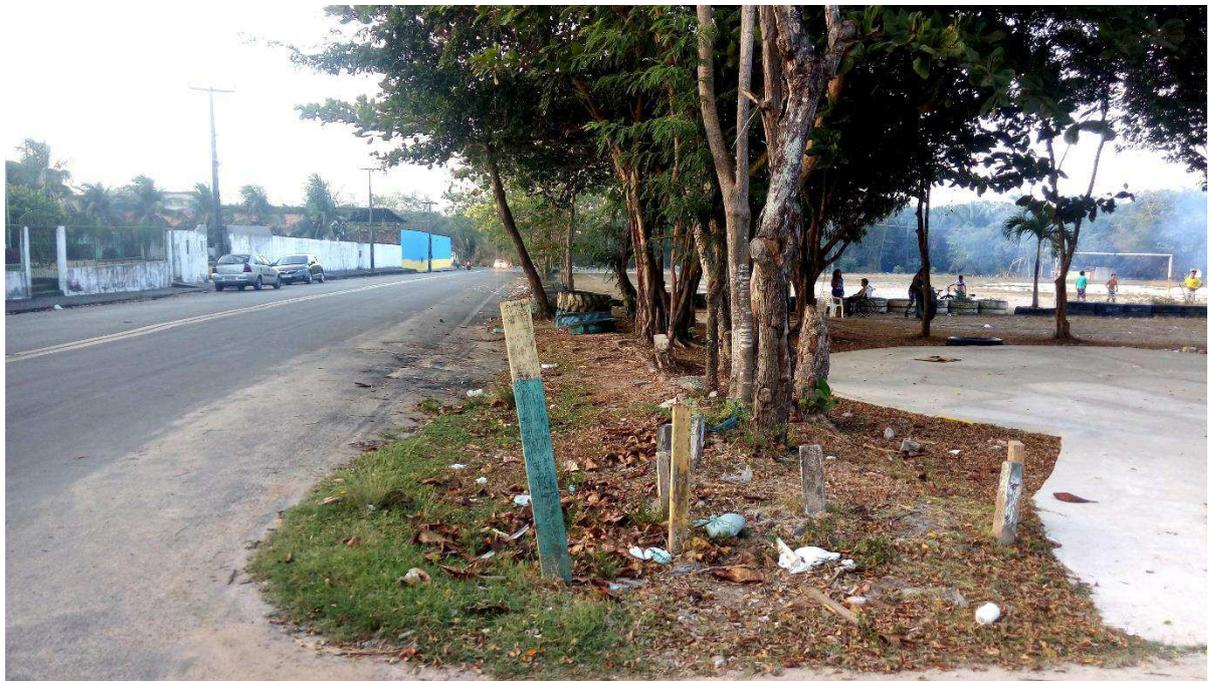
**DESCRIÇÃO:** Ausência de passeio em todo o entorno da praça, fator que estimula o pedestre a circular pela via. Pavimentação inadequada, com ausência de rampas de acesso (conforme o item 6.12.7.3 da NBR 9050). Ausência de sinalização tátil direcional e de alerta.
