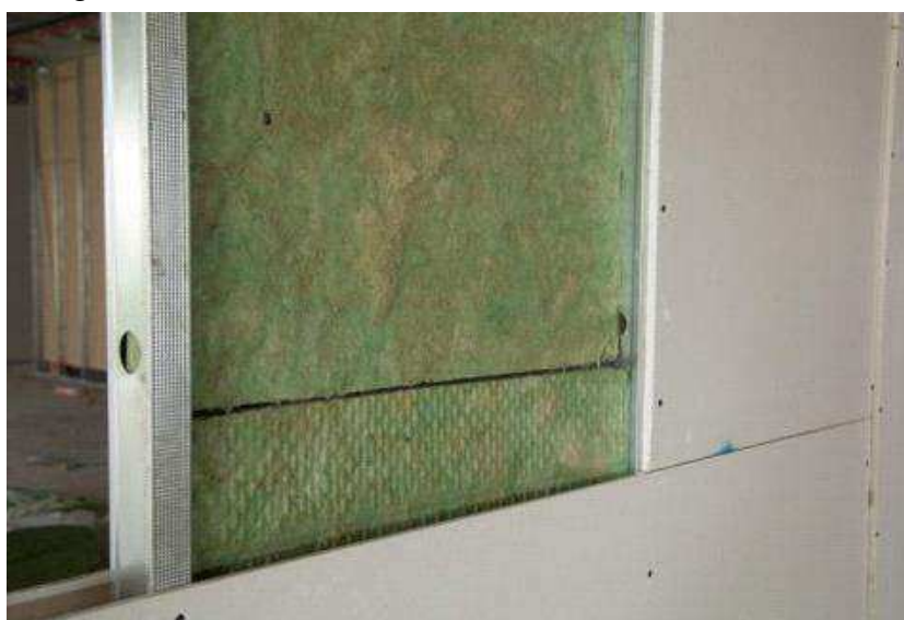
Figura 41- Tratamento acústico utilizando lã de rocha.
