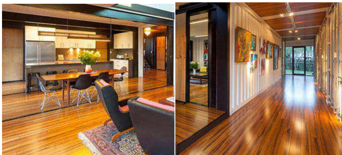
Figura 44- Revestimento em piso vinílico no container.
