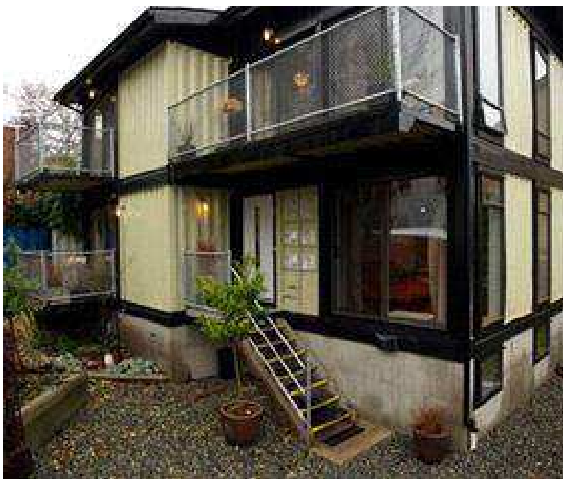
Figura 34- Utilização do sistema de fundação tipo radier.
