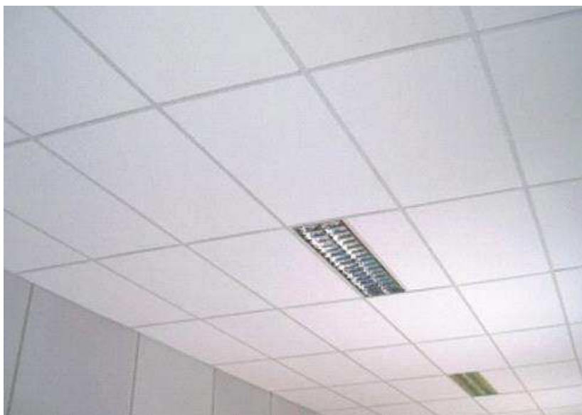
Figura 42- Forro de Isopor instalado no teto.
