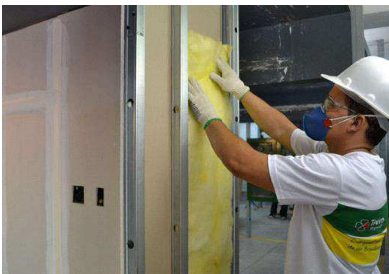
Figura 40- Instalação da lã de vidro em parede de drywall.
