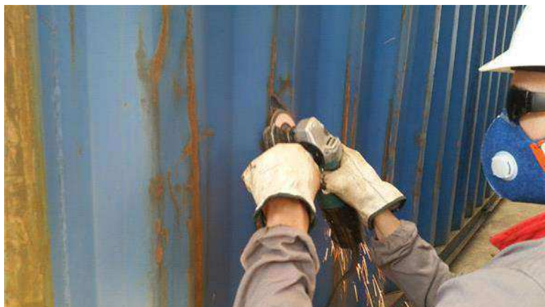
Figura 35- Tratamento da superfície do container antes de receber a pintura.
