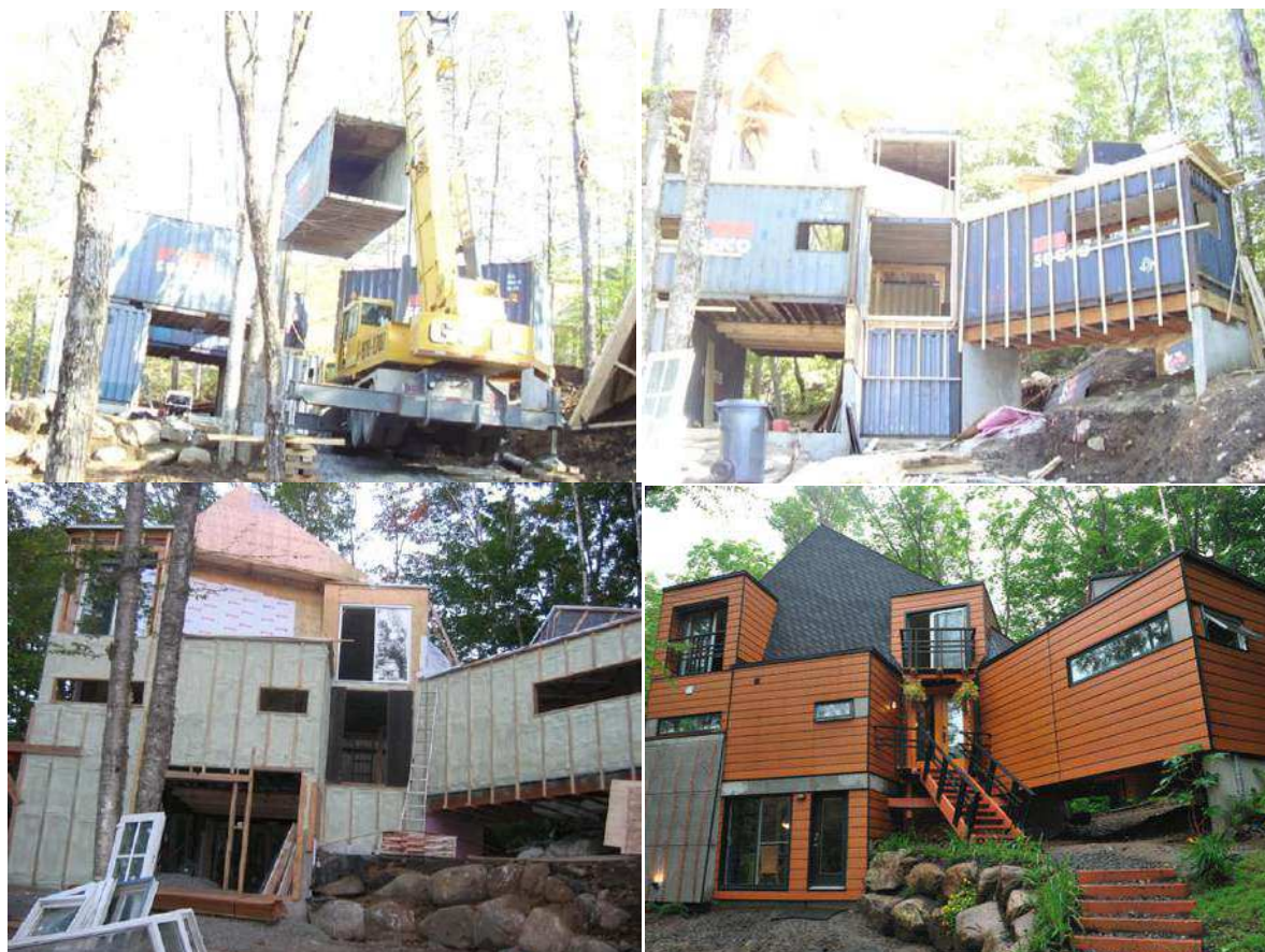
Figura 43- Fases de implantação do revestimento externo em tiras de madeira.
