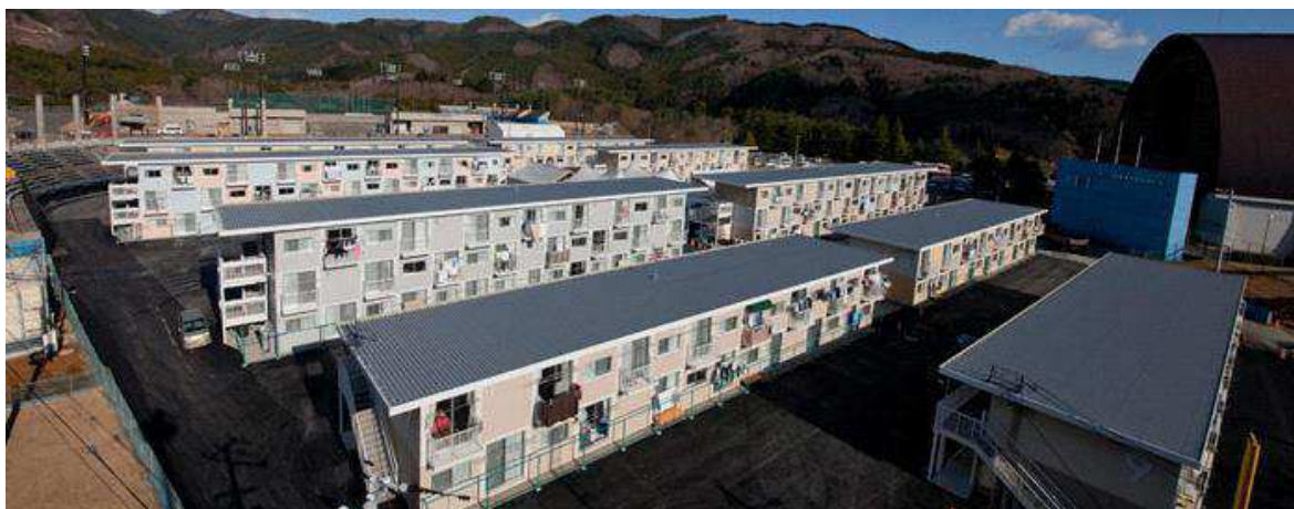
Figura 30- Disposição dos prédios em container no antigo campo de beisebol.
