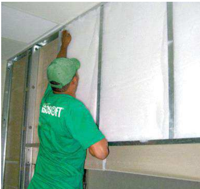
Figura 39- Aplicação do isolante lã de pet na parede.
