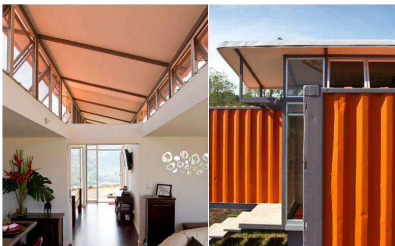
Figura 15- Foto do interior e exterior da residência, e o detalhe da cobertura.
