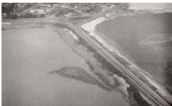
Figura 12 - Cartão postal da construção da Barragem do Bacanga. Emitido por Mercator, datado em 28 de setembro de 1972.
