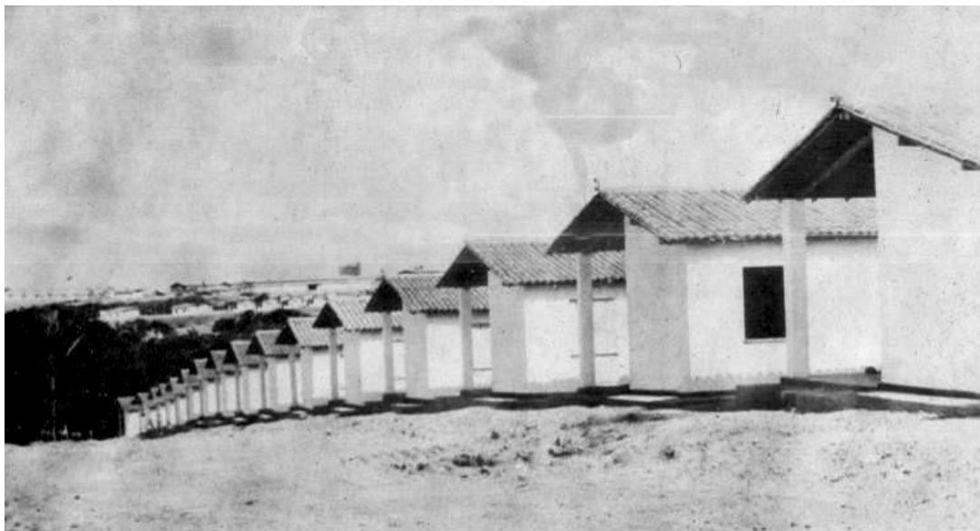
Figura 20 - Conjunto Vinhais em construção.
