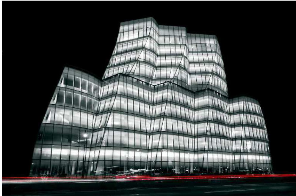
Figura 13 - Edifício IAC, Nova York, E.U.A.
