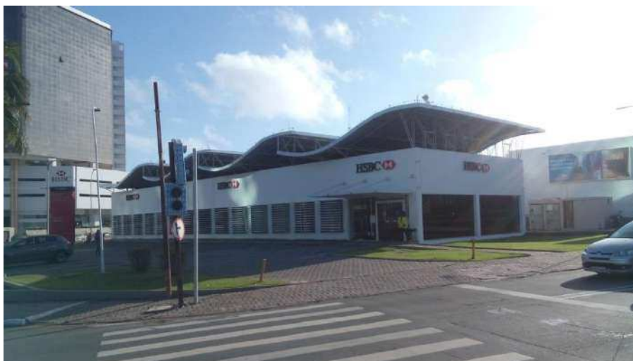
FACHADA PRINCIPAL HSBC PREMIER AGÊNCIA RENASCENÇA
