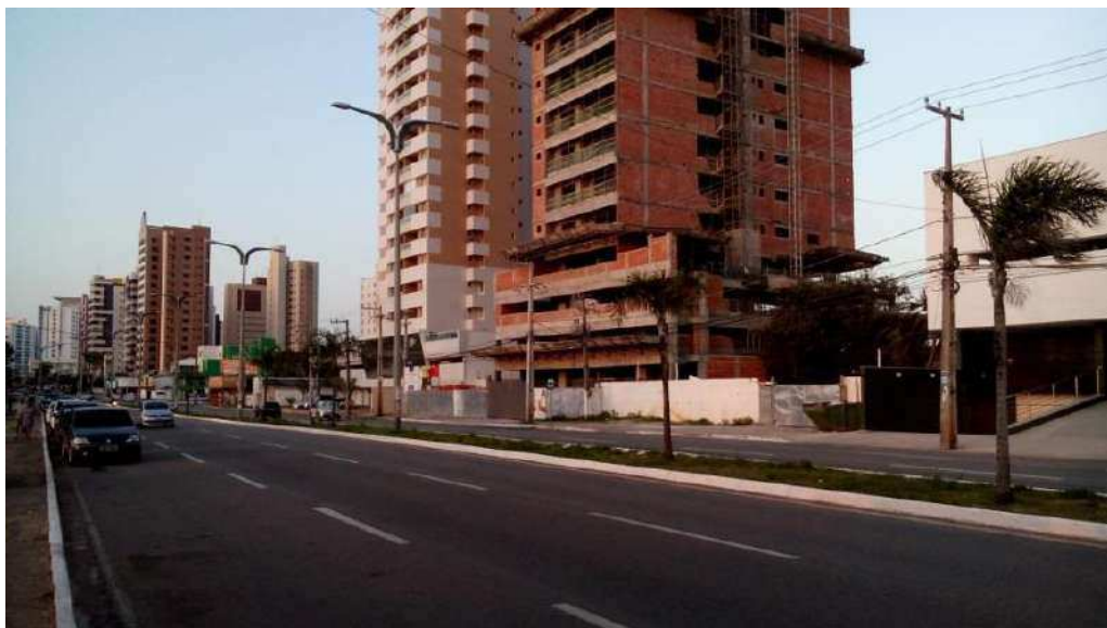
IMAGEM DA AVENIDA ONDE O TERRENO ESTÁ LOCALIZADO
