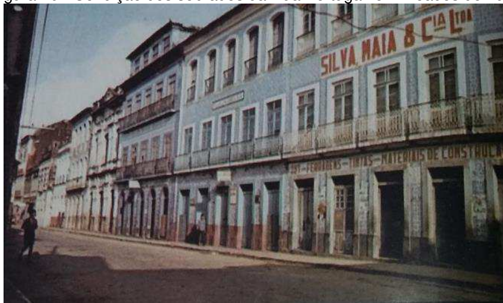
Figura 40 - Condição dos sobrados da Rua Portugal em meados de 1970
