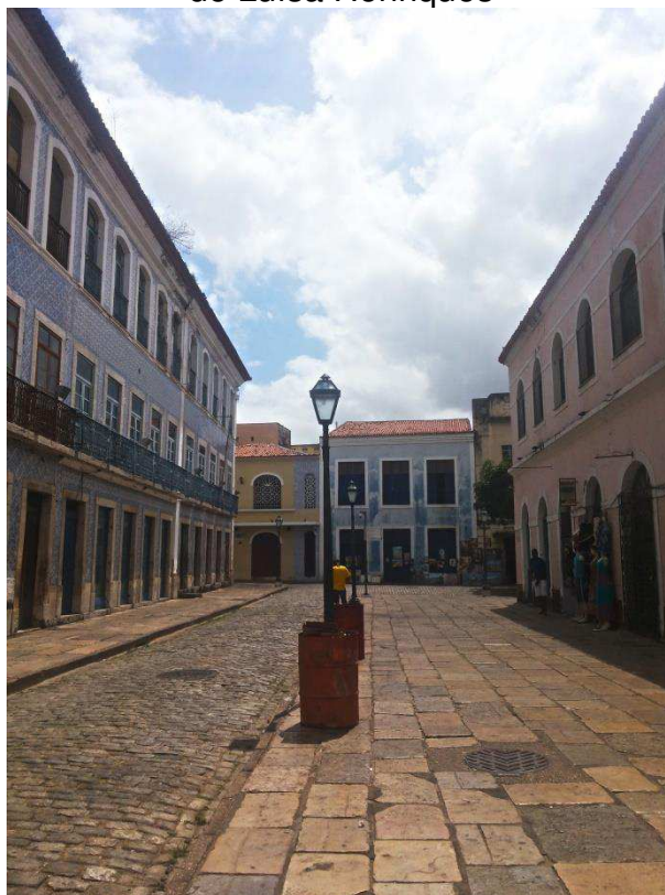
Figura 65 - Encontro da Rua da Estrela (ao fundo) com a Rua Portugal. Fotografia de Luísa Henriques
