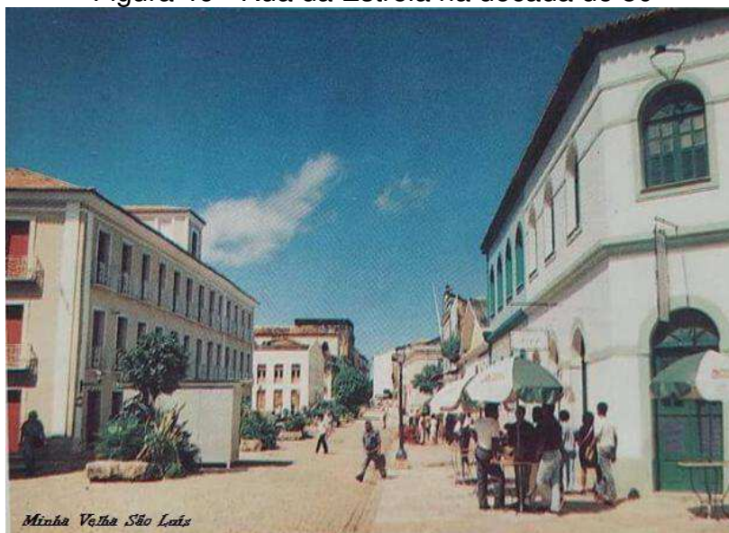
Figura 46 - Rua da Estrela na década de 80
