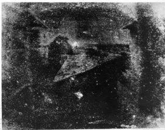
Figura 3 - Vista da Janela em Les Gras.
