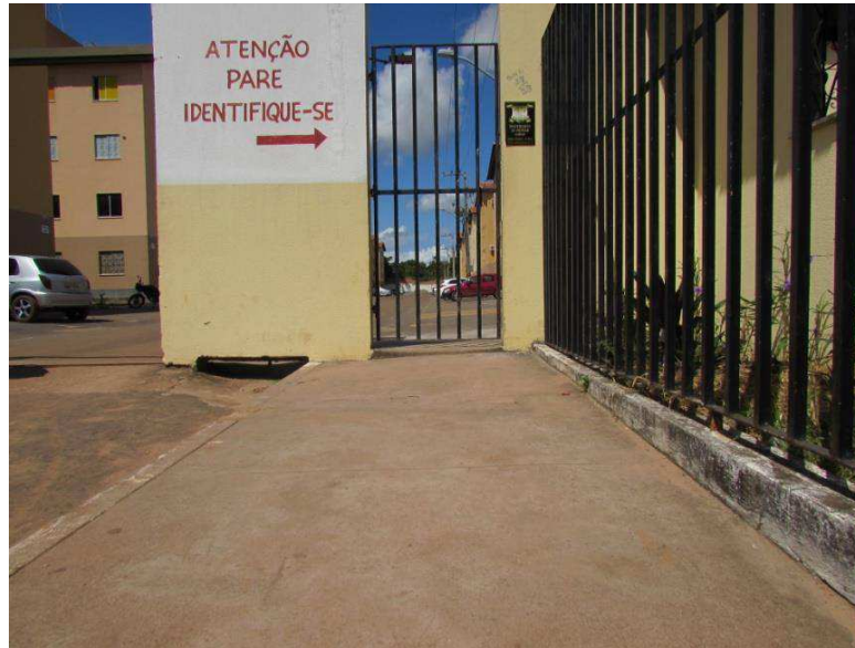
Imagem 39 – Portão para pedestres no Conjunto são José III
