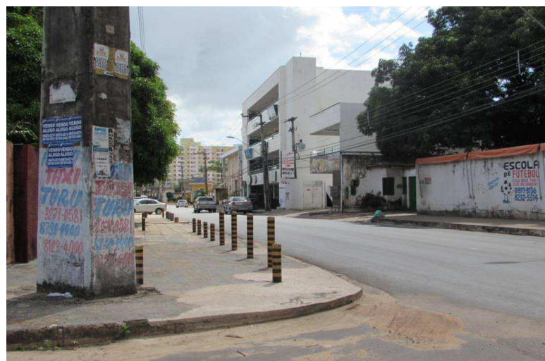
Imagem 7 – Elementos que colocam em risco a segurança na Rua do Aririzal em São Luís
