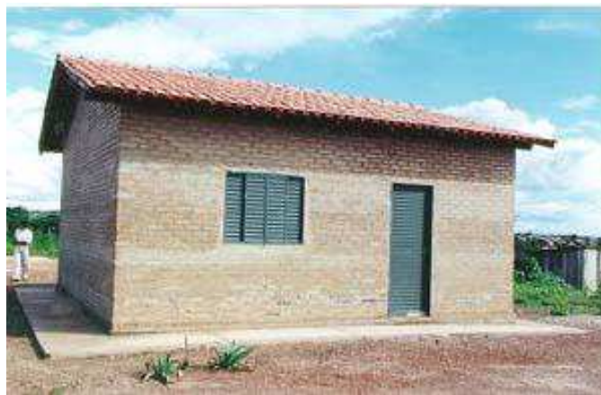
Figura 47: Casa popular feita com tijolos de solo-cimento em Cuiabá-MT. Fonte: http://www.forumdaconstrucao.com.br/conteudo.php?a=23&Cod=124
