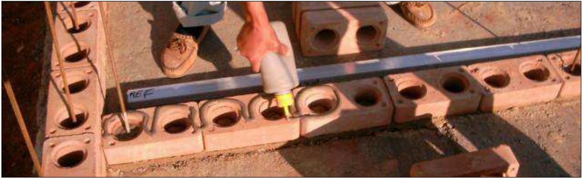
Figura 9: Assentamento dos tijolos.
