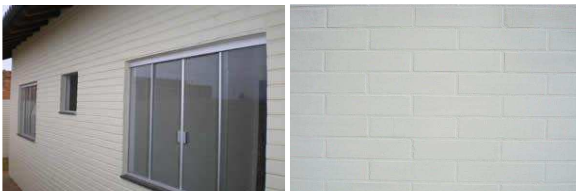
Figura 51: Pintura externa em alvenaria de tijolo de solo-cimento. Fonte: http://www.tijolo.eco.br/tijolo-ecologico/conheca-o-tijolo-ecologico/
