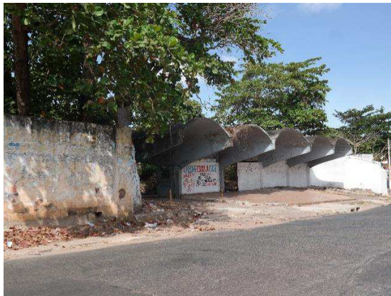
Foto 67 - Entrada do Clube Lítéro e a Cobertura
