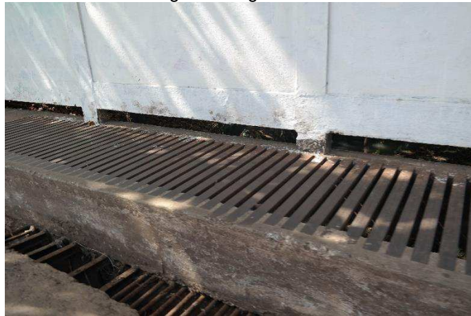
Foto 60 - Galeria Existente na Calçada do Lítro Para Drenagem da Água da Chuva
