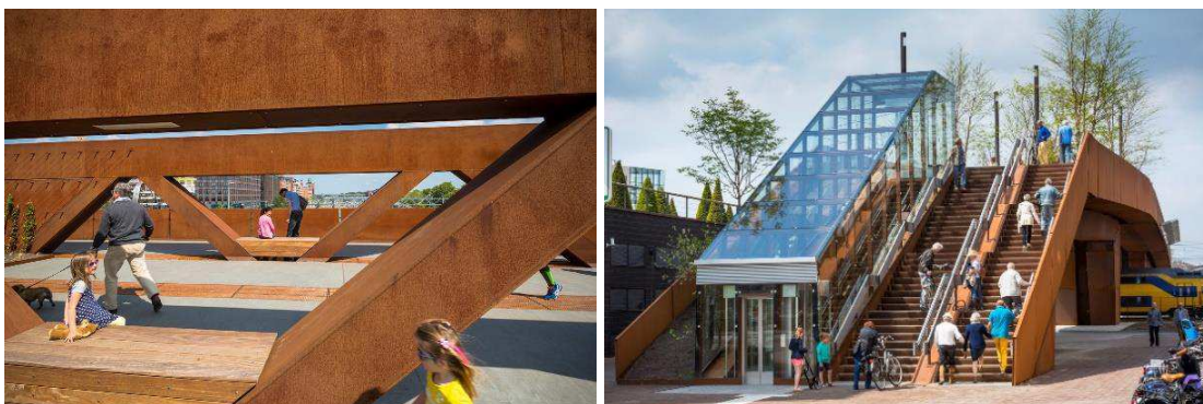
Foto 45 - O Mobiliário Urbano e o Acesso à Passarela Pelas Escadas e o Elevador Panorâmico
