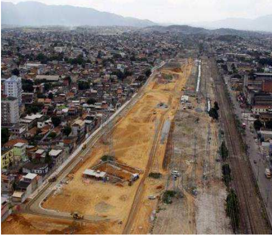
Foto 50 - Parque Madureira Durante a Execução do Projeto
