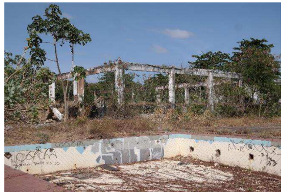
Foto 66 - Estrutura do Salão de Festas Principal e da Piscina Adulto
