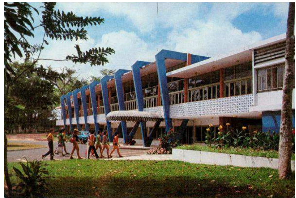
Foto 57 - Entrada Principal do Cube Jaguarema
