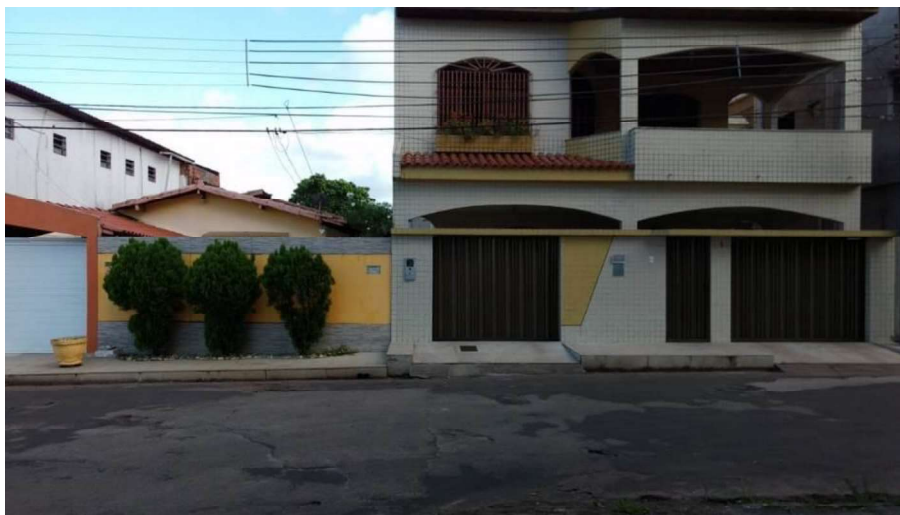
Figura 46: Lote residencial próximo a fachada oeste da praça, com fachada inativa
