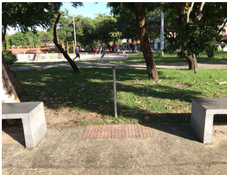
Figura 9: Suporte para apoio de lixeiras. Mobiliário urbano sem manutenção.
