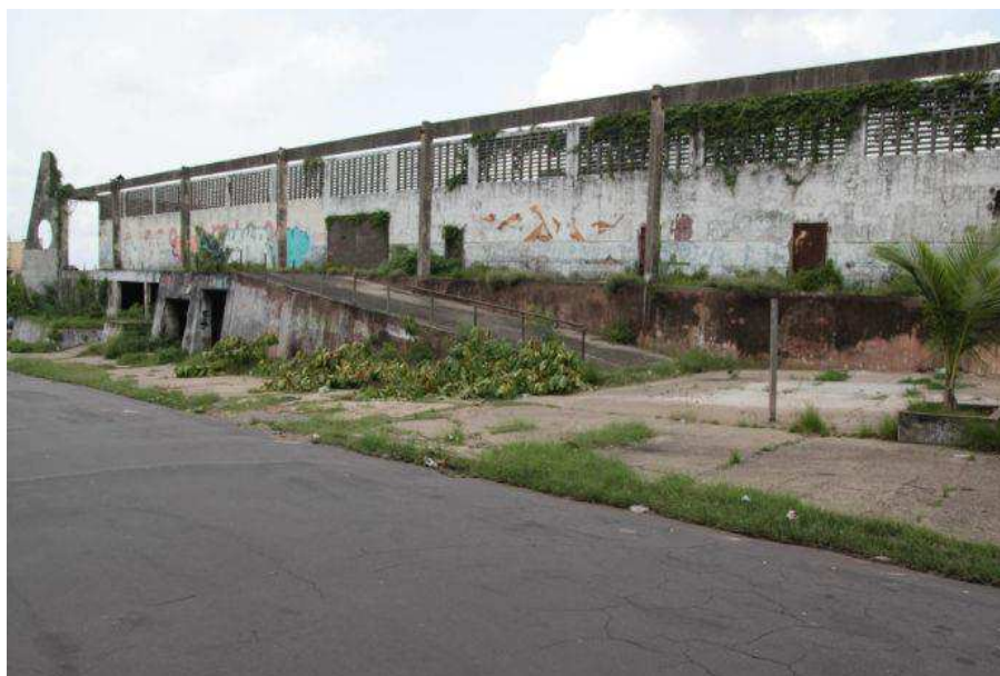
Figura 26. Estrutura Horto mercado Monte Castelo 2 Fonte: Site Imirante, 2018.
