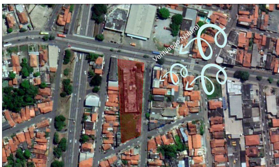
Figura 29. Ventilação Fonte: Google Earth com sobreposição do autor, 2018.
