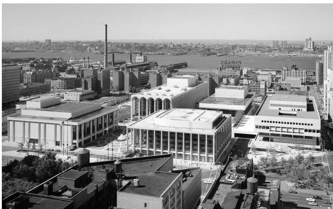
Figura 14. Complexo Lincoln Center com Juilliard à direita Fonte: Site Nycurbanism, 2018.
