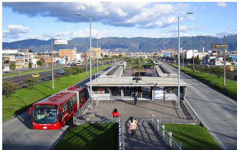
Figura 5 - Estação de embarque do TransMilenio
