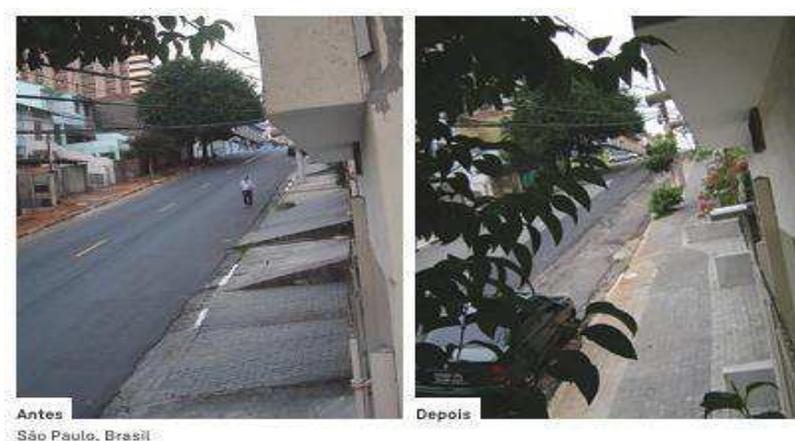
Figura 41 - Requalificação da calçada para melhoria da acessibilidade de pedestres, em São Paulo.
