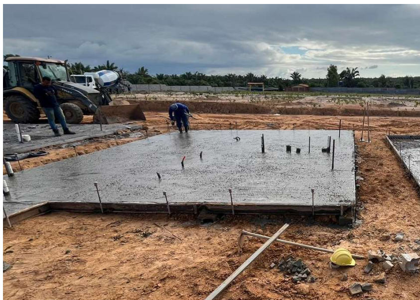
Figura 2 – Radier em concreto armado.
