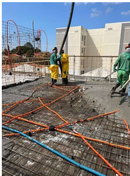
Figura 31 – Concretagem
