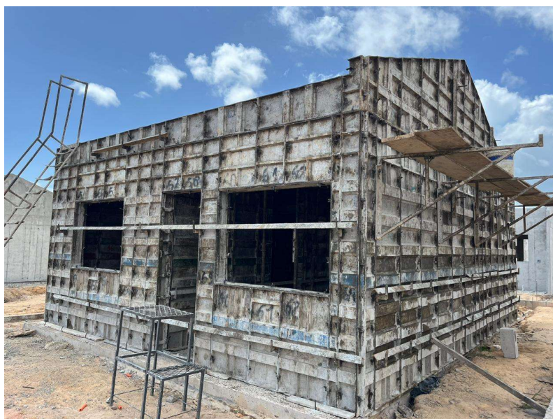
Figura 29 – Forma Montada
