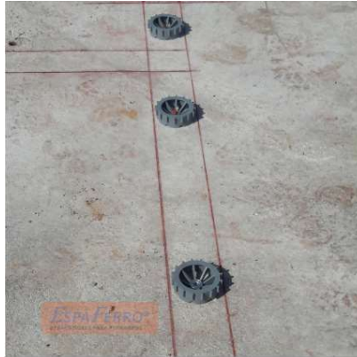
Figura 17 – Espaçadores tipo Galga.
