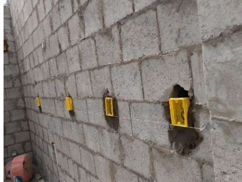
Figura 15 – Instalação de pontos elétricos.
