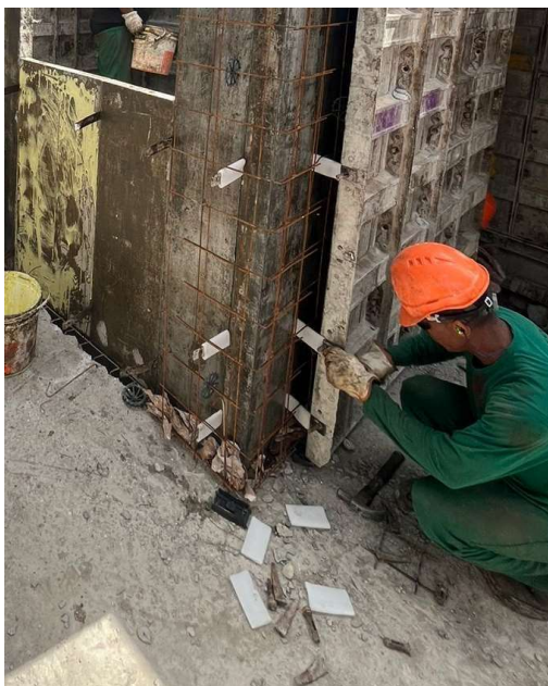
Figura 28 – Protetor de presilha na forma.
