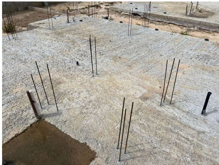
Figura 18- Arranques para fixação de paredes
