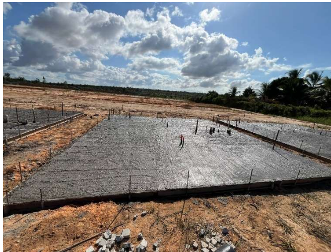
Figura 16 – Radier armado.
