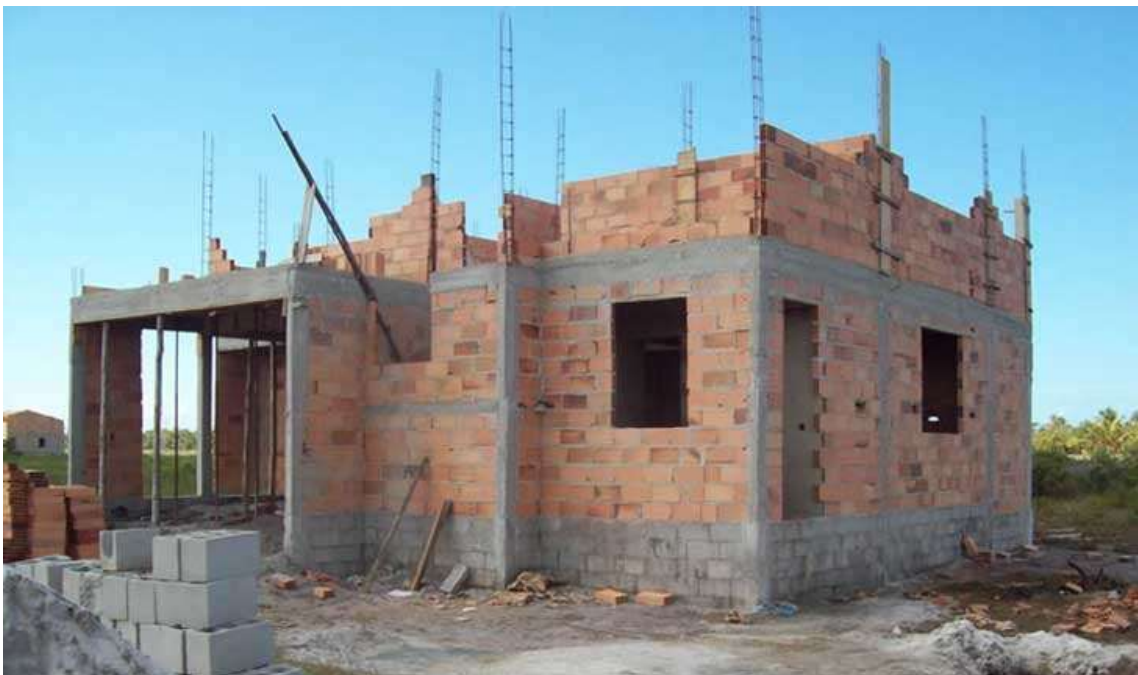
Figura 1- Sistema construtivo em alvenaria convencional
