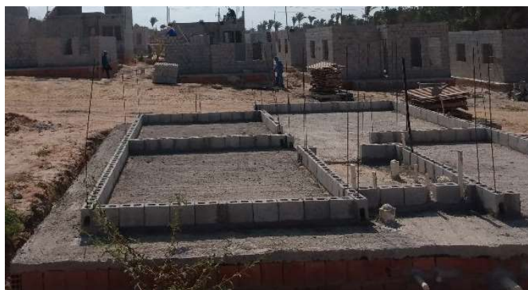
Figura 11- Marcação de alvenaria
