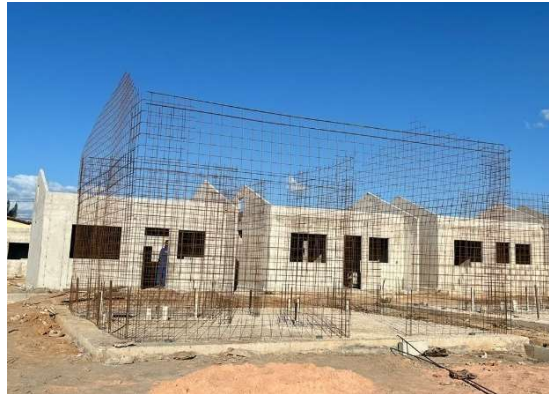
Figura 19 – Armação das paredes
