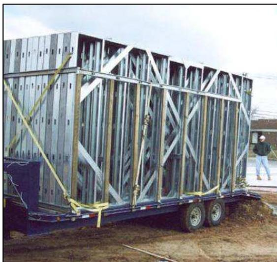
Figura 10 - Painéis pré-fabricados levados para montagem em obra
