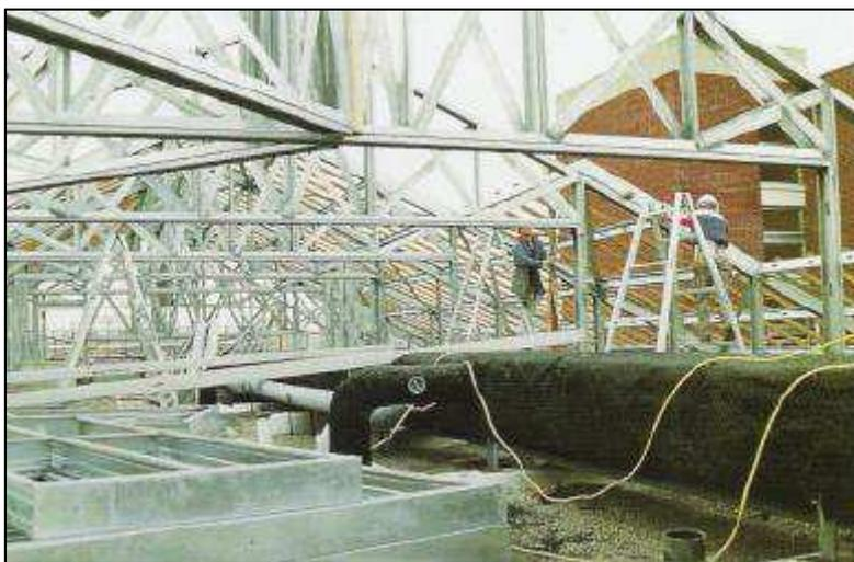
Figura 7 - Reforma de telhados substituindo por tesouras fabricadas com perfis formados a frio
