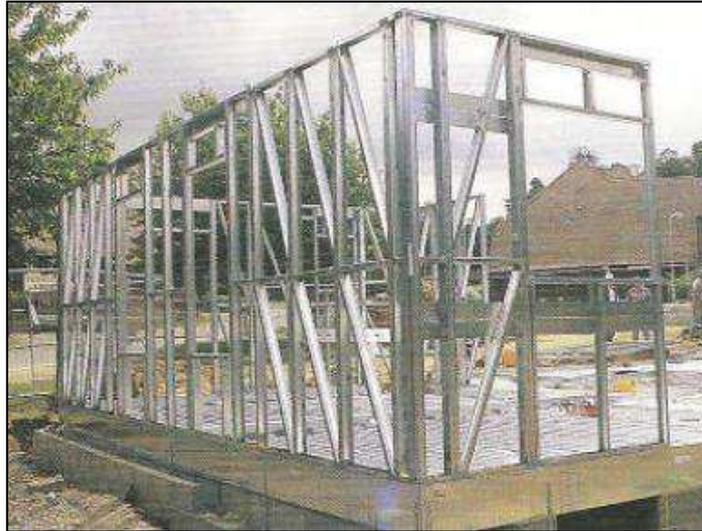
Figura 14 - Estrutura de painel contraventamento em K
