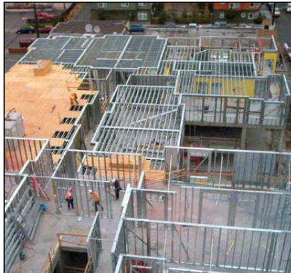
Figura 17 - Laje de Steel Framing em produção
