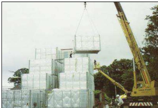
Figura 11 - Módulos pré-fabricados sendo entregue em obra
