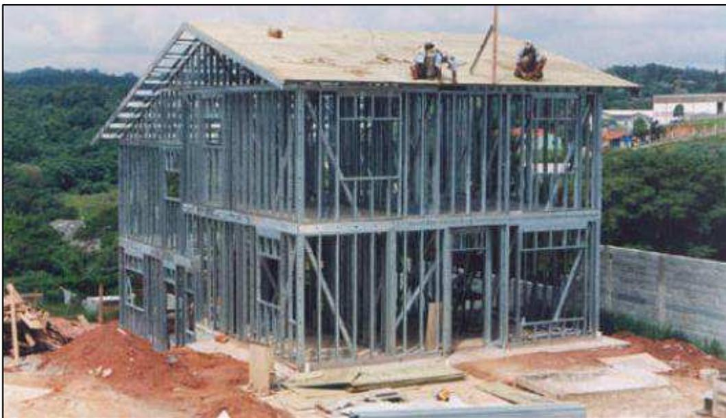
Figura 1 - Estrutura de residência em Light Steel Framing
