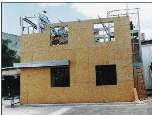
Figura 26 - Vedação com Placas de OSB
