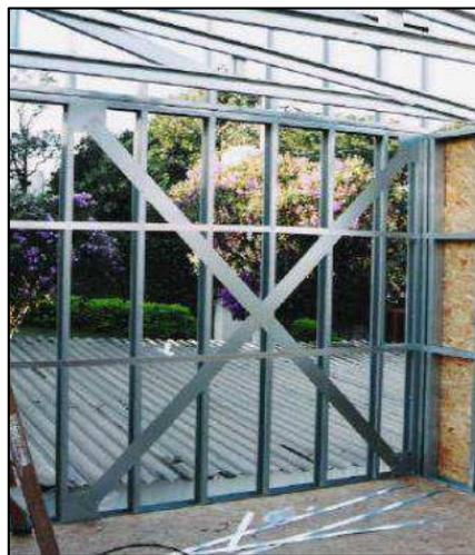
Figura 13 - Estrutura de painel contraventamento em X
