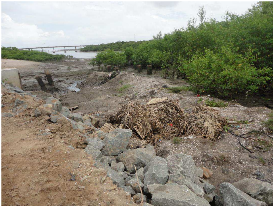
Figura 46- Aterro no bairro da Liberdade para a construção da Avenida IV Centenário
