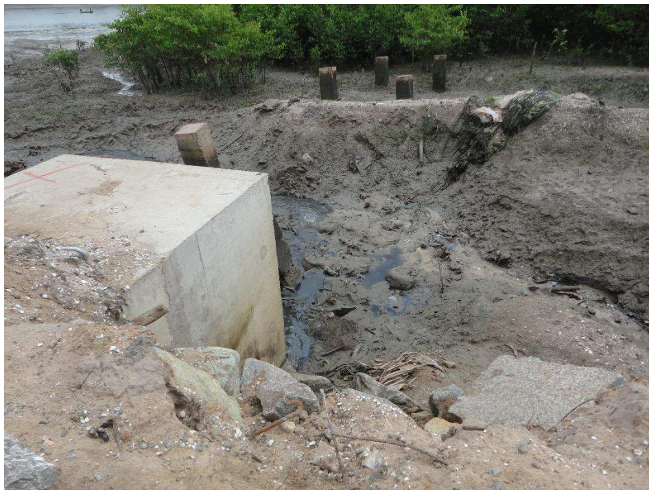
Figura 47- Fundações na área de mangue no bairro da Liberdade.
