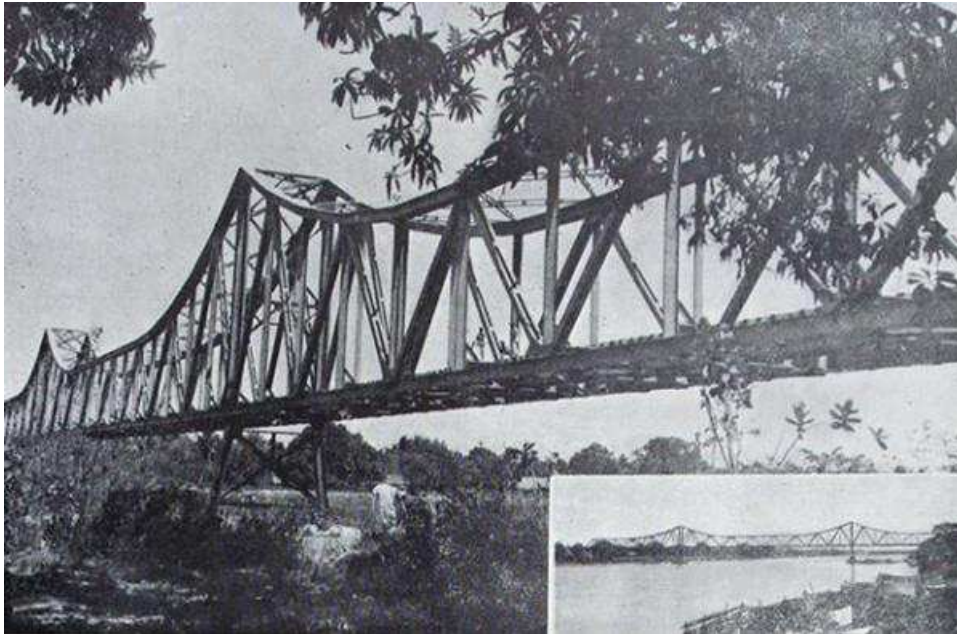
Figura 17 - Ponte Ferroviária sobre o rio Parnaíba, ligando o Maranhão ao Piauí
