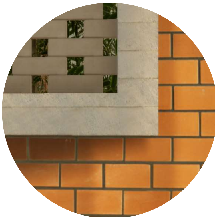
Figura 42: Acabamentos da fachada
