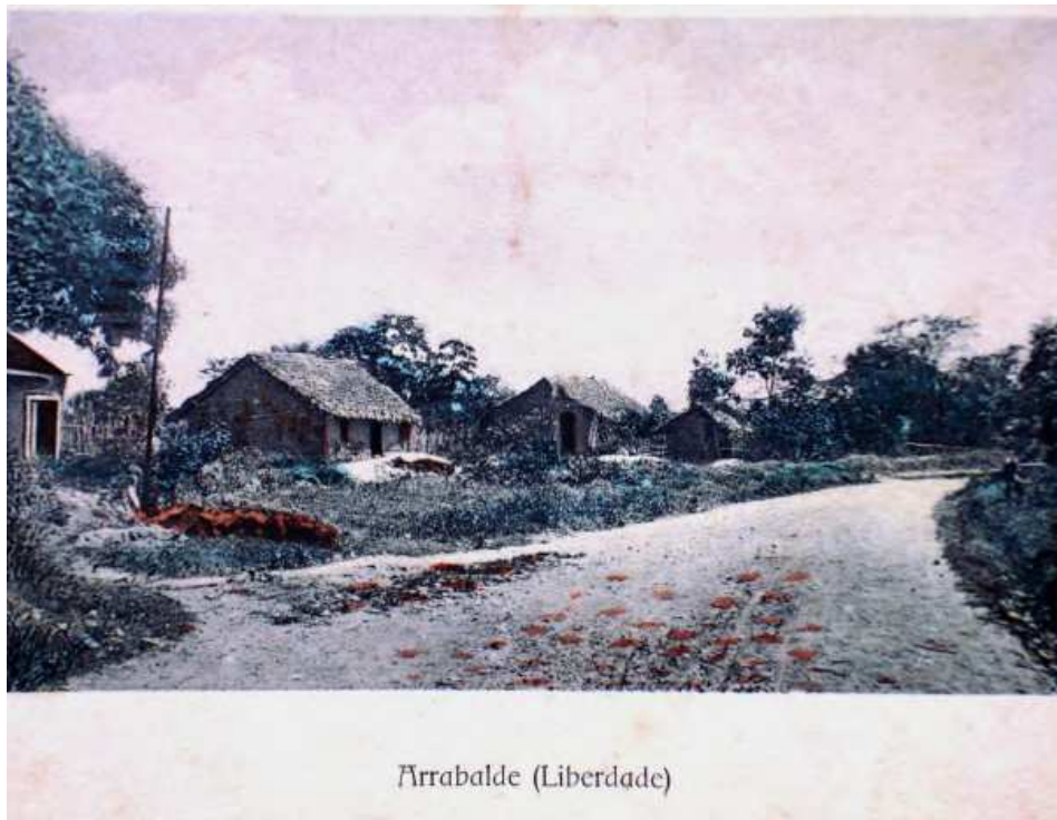
Figura 13 : Área do bairro da Liberdade, com moradias construídas em palha e barro.
