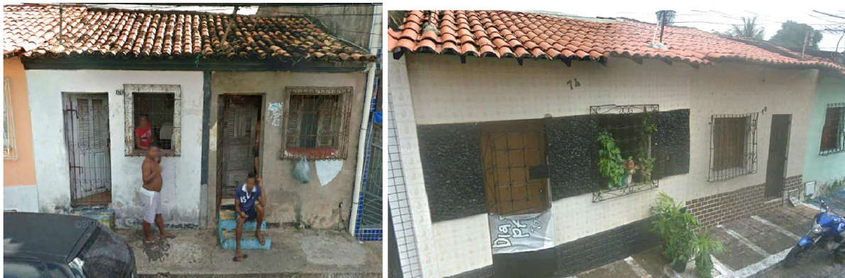
Figura 27 e 28 : Moradias encontradas na Rua Côrrea Araújo e na Rua Orlando de Barros, próximas ao Promorar
