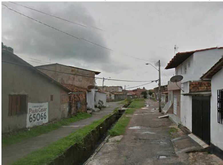
Figura 20: Rua da Vala, com canalização aberta, limitando o tráfego de pessoas
