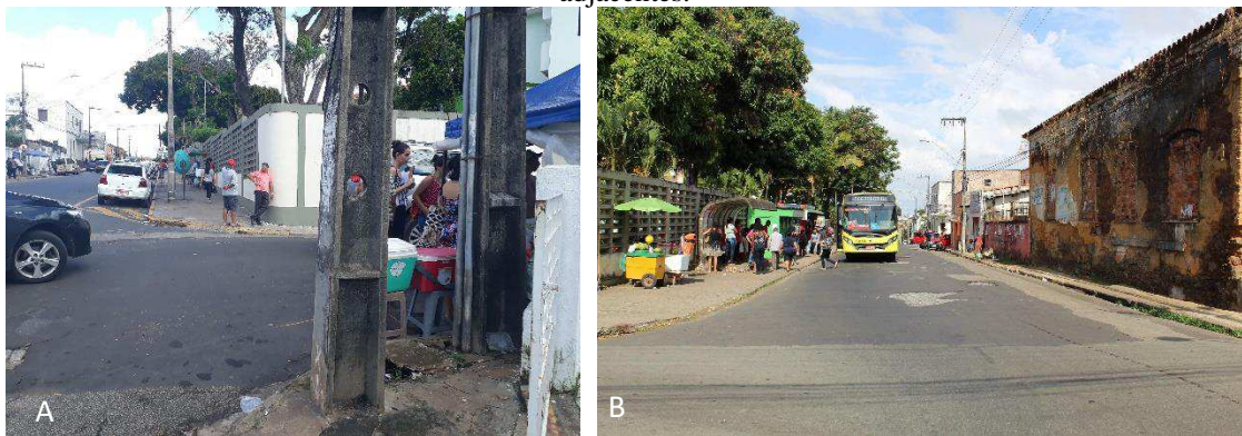
Figura 18 - Ausência de rampas de acessibilidade e sinalização nas travessias entre a Rua Barão de Itapari e adjacentes.
