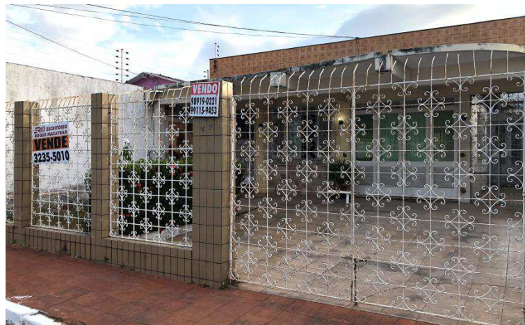
Figura 64 - Residência com platibanda, gradil e azulejos no muro
