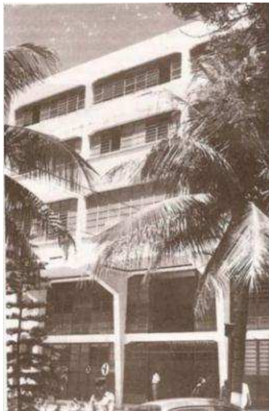
Figura 16 - Hospital da Brigada Militar, Recife-PE
