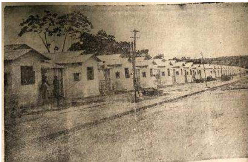
Figura 44 - Obra do conjunto residencial do Filipinho na fase de acabamento
