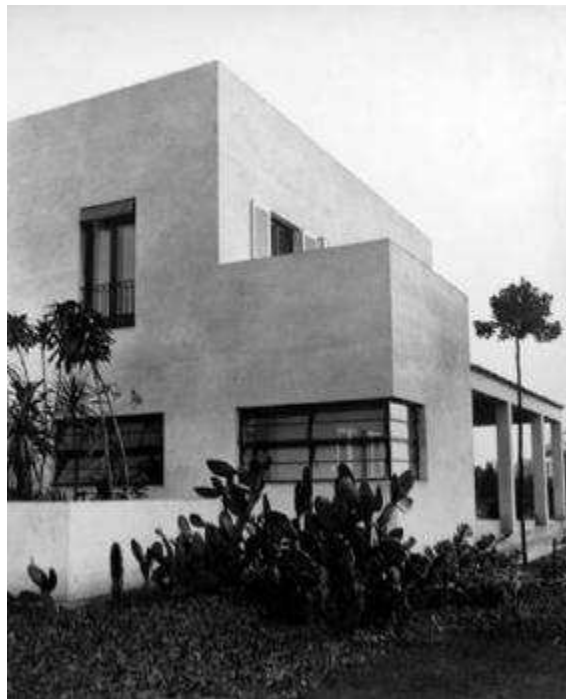
Figura 8 - Janelas horizontais da casa Moderna da rua Santa Cruz.
