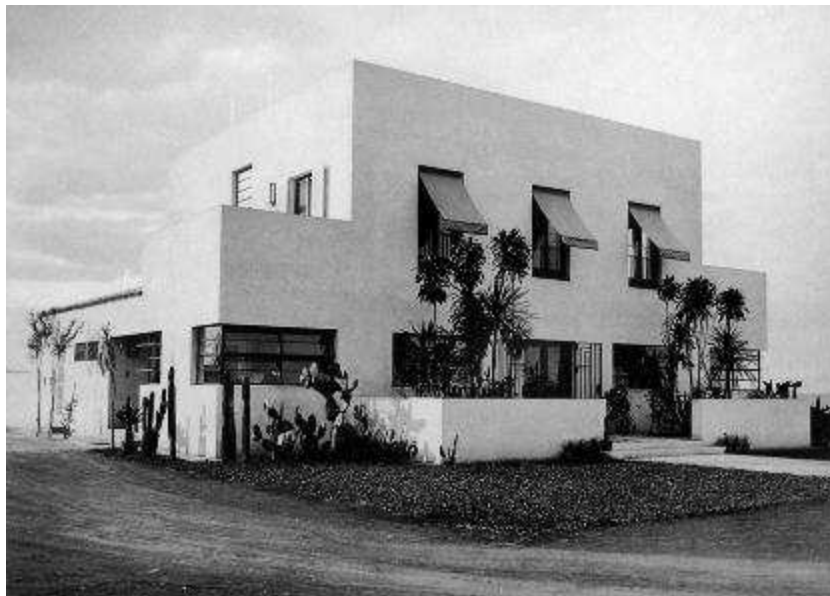
Figura 5 - Casa Moderna da rua Santa Cruz, na Vila Mariana, São Paulo-SP
