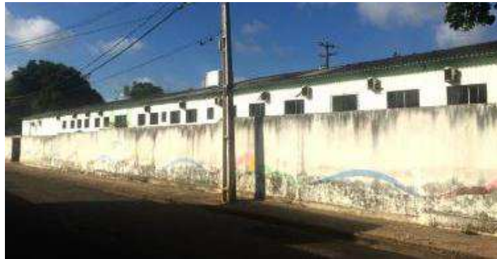
Figura 88 - Fachada lateral direita do Hospital PAM Filipino em 2018
