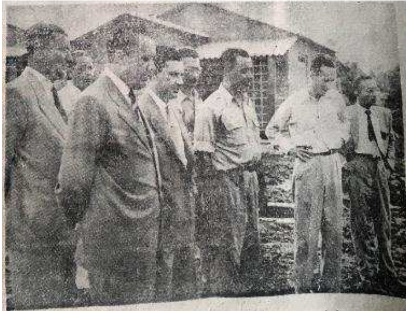
Figura 38 - Inspeção realizada na obra do Filipino em 20 de janeiro de 1950
