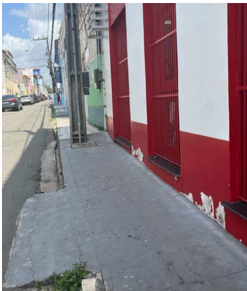
Figura 47 - Rampa no acesso principal do Casarão nº.270. Fonte: Autora, 2024.
