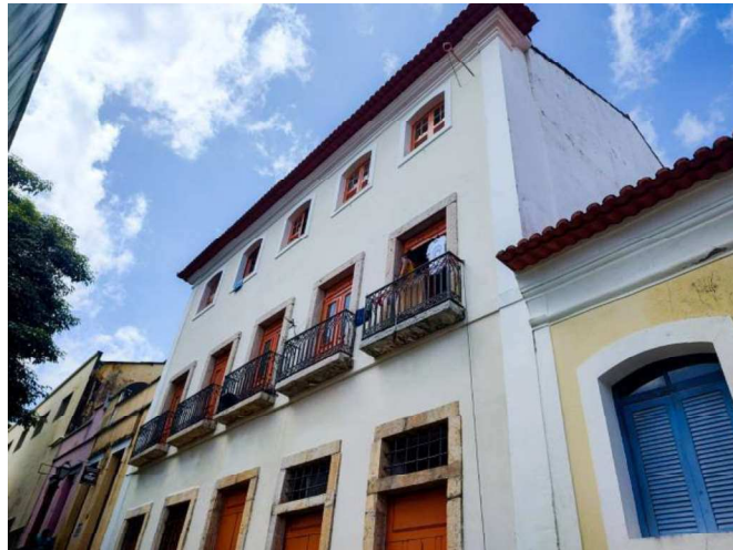
Figura 22 - Residencial Pacotilha nº 36 após reforma.
