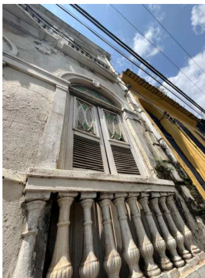
Figura 42 - Janela na fachada principal.
