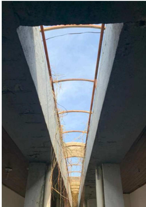
Figura 37 - Claraboia com cobertura em Policarbonato.
