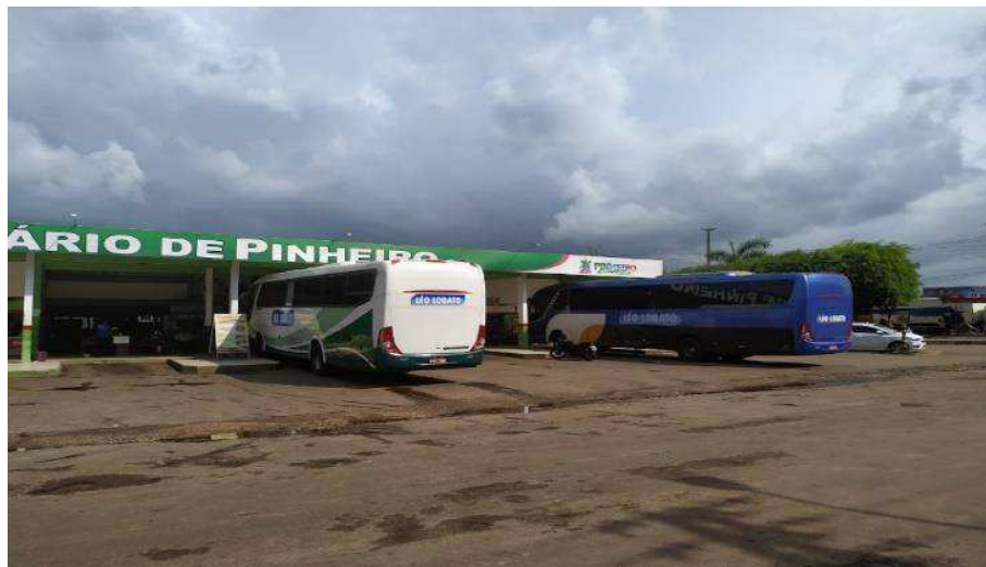
Figura 2 – Terminal Rodoviário de Pinheiro – MA
