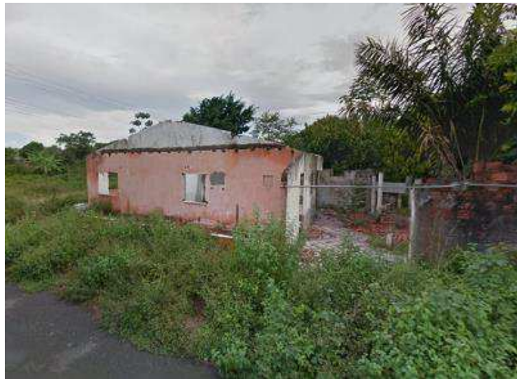
Figura 9 - Casa em ruína
