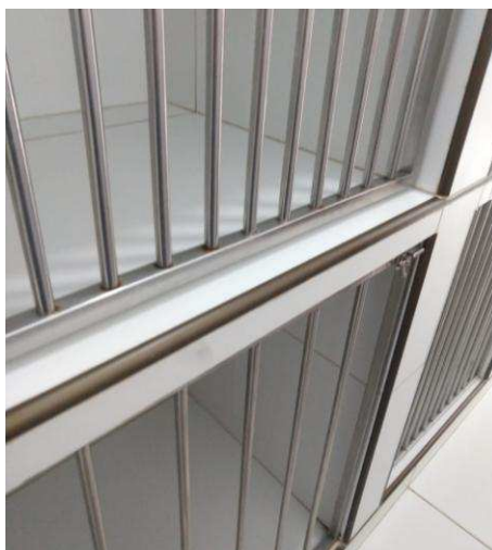
Figura 7 –Detalhe de proteção das bordas dos canis - Clínica veterinária e Hotel Anjos de Pelos
