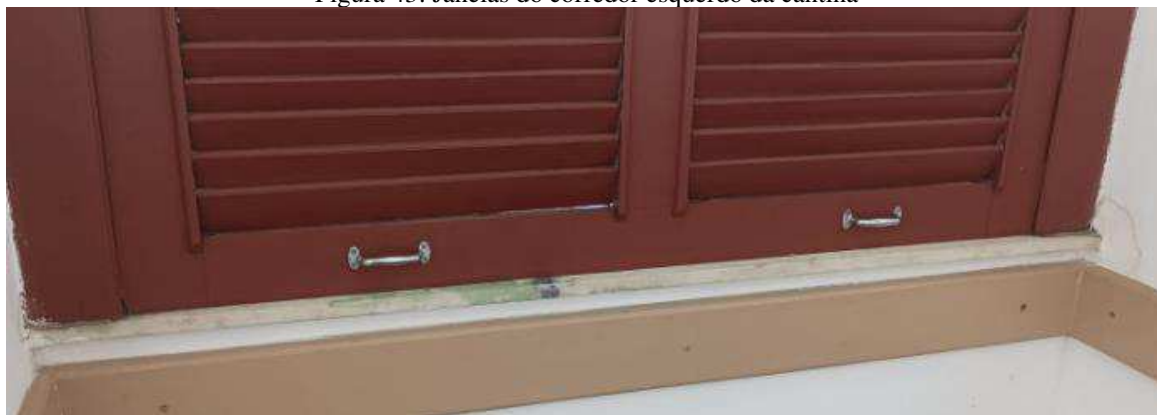
Figura 43: Janelas do corredor esquerdo da cantina
