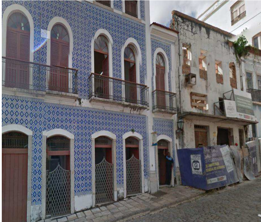
Figura 5: Imagem do prédio anexo antes da reforma
