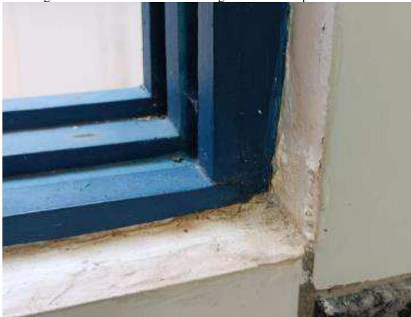
Figura 42: Banheiro feminino do segundo andar do prédio de anexo
