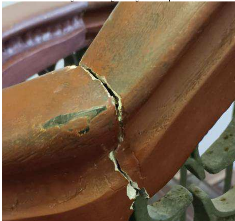
Figura 22: Imagem de guarda corpo
