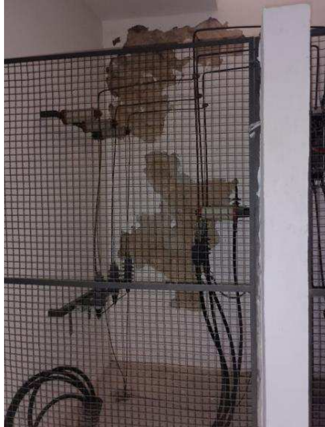
Figura 30: Pintura da Subestação
