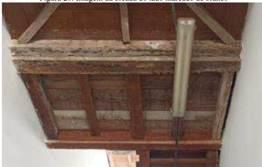
Figura 20: Imagem da escada do lado marcado de branco
