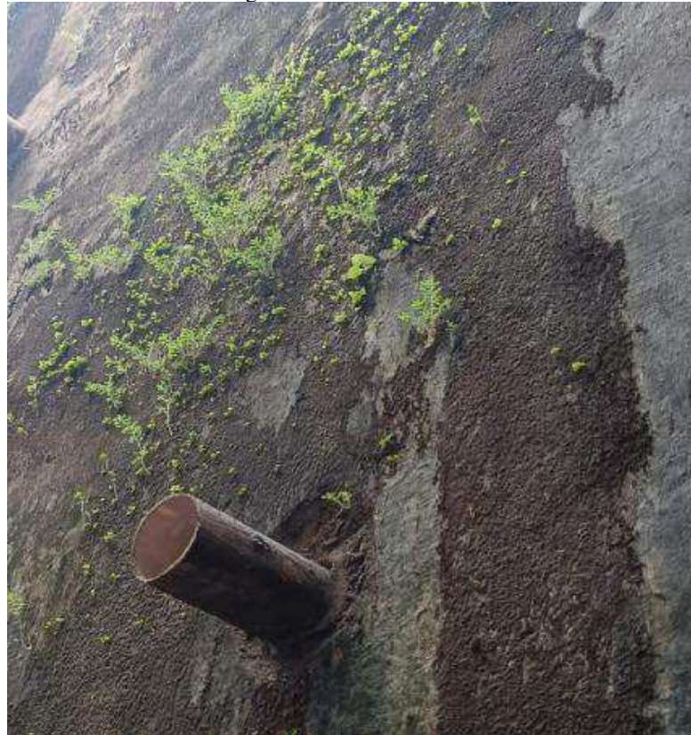
Figura 27: Muro de arrimo
