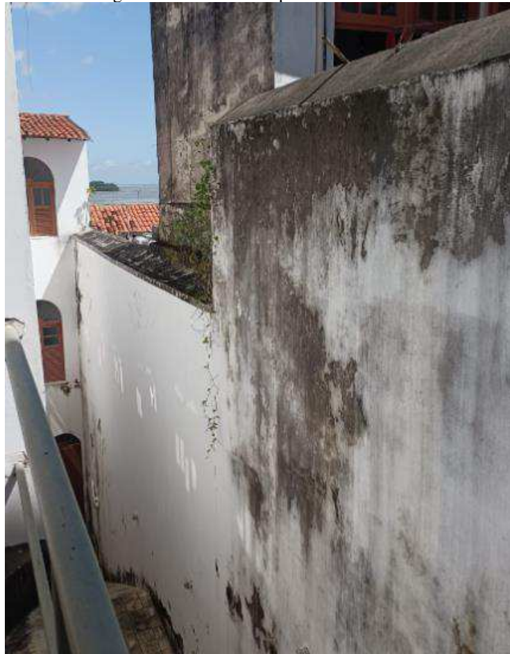
Figura 45: Área externa perto dos banheiros
