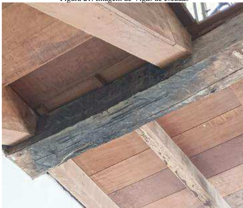
Figura 21: Imagem de Vigas de escadas
