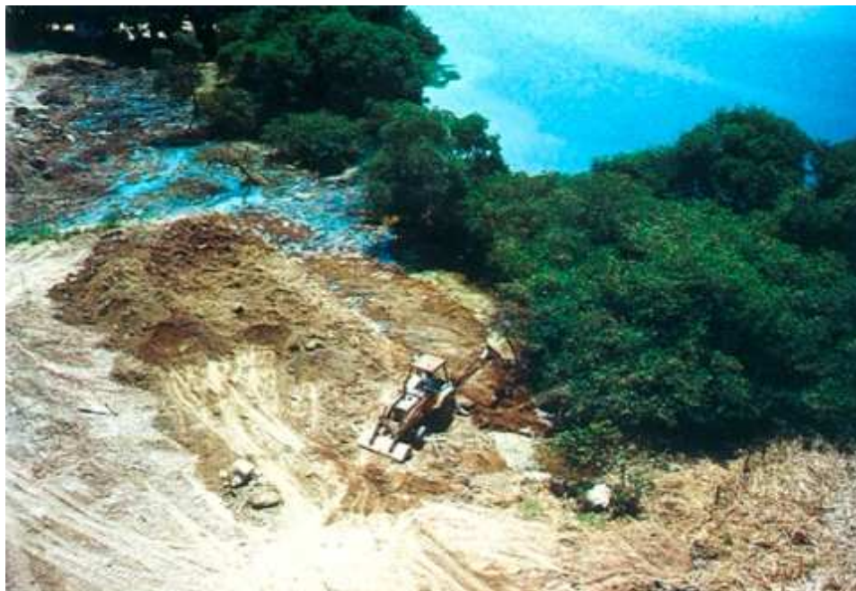
Figura 25. Operação de terraplanagem para otimização do terreno e desaterro de áreas para reimplantação do mangue.
