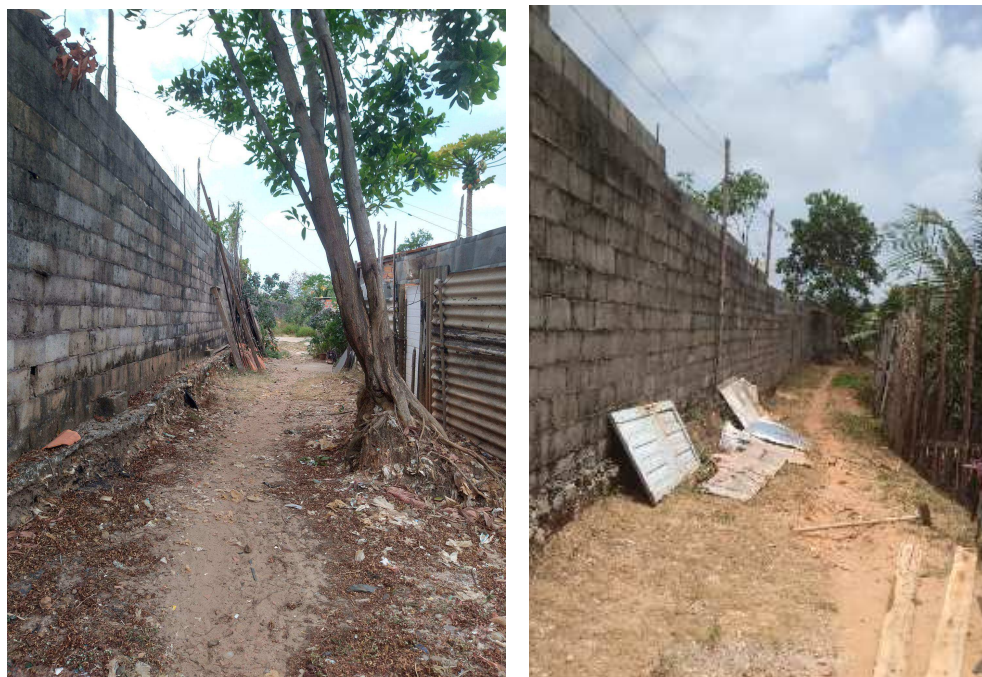
Figura 52 e 53. Muro que limita o terreno do São Luís Shopping
