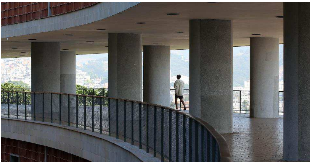
Figura 20 – Pavimento livre no Conjunto Pedregulho.
