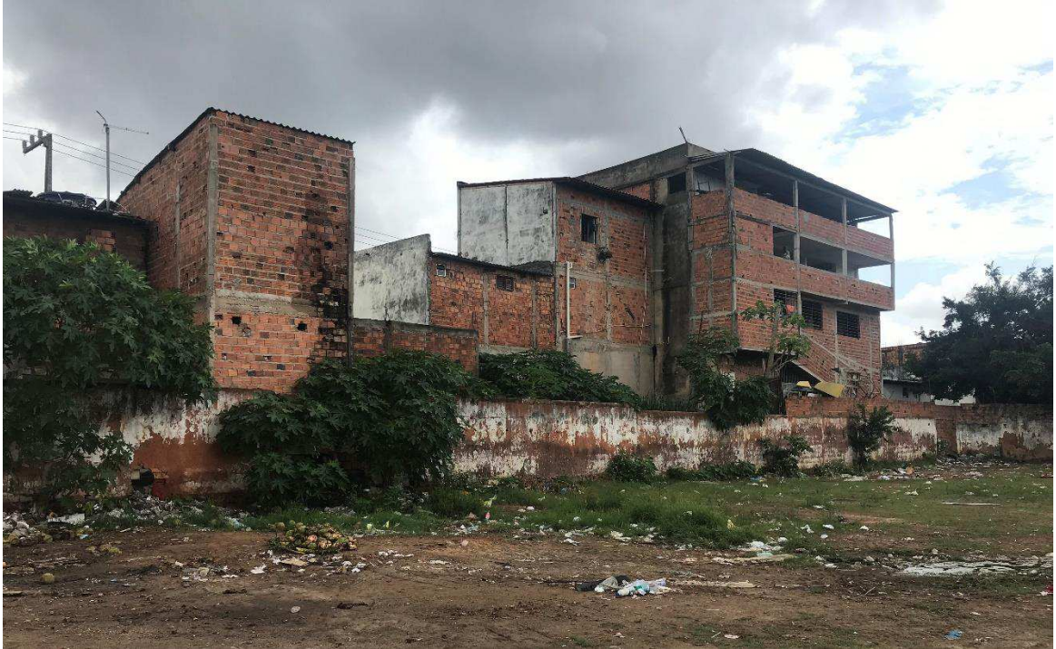
Figura 30 – Detalhe do fundo das edificações vizinhas ao terreno, que tem sua frente voltada à Av. Ana Jansen.
