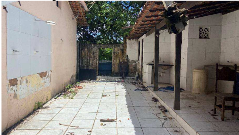
Figura 44 - Fachada posterior e lavanderia.
