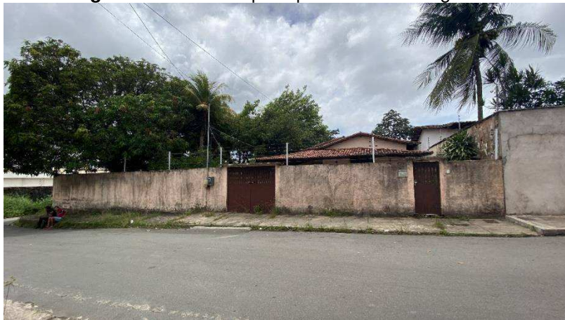
Figura 40 - Fachada principal – Rua das Begônias.
