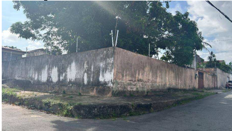
Figura 41 - Fachada lateral – Rua dos Antúrius.
