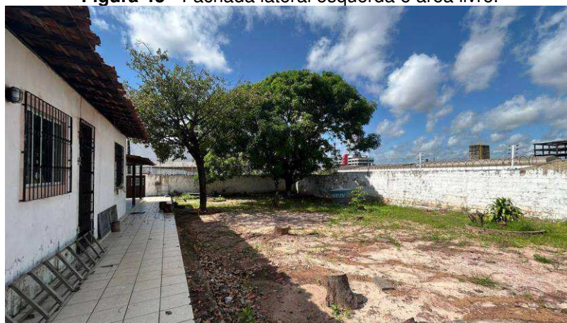
Figura 43 - Fachada lateral esquerda e área livre.
