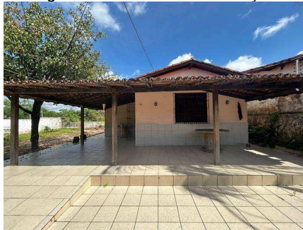
Figura 42 - Fachada frontal - edificação.
