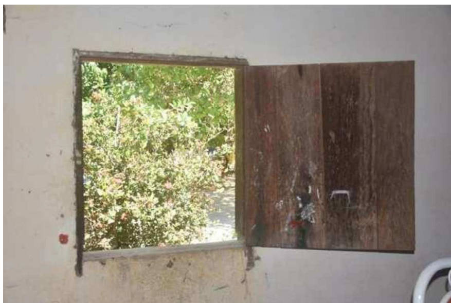
Figura 27 - Janela de madeira - Território Saco das Almas, Brejo/MA.
