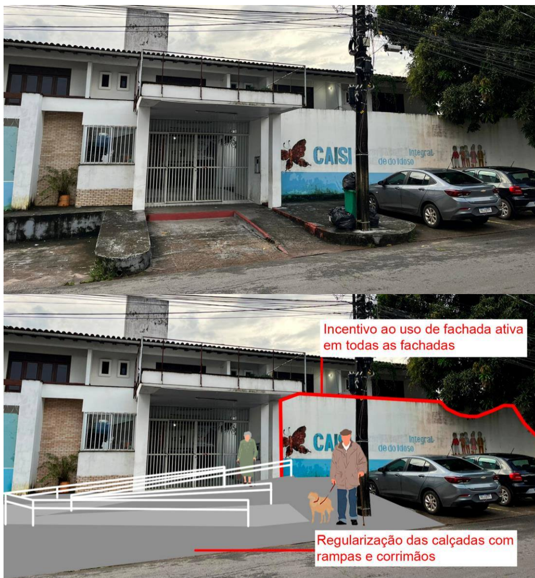
Figura 75 – Entrada principal do CAISI: situação atual x croqui com recomendações
