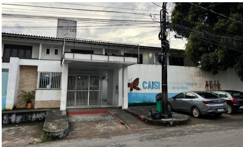
Figura 15 - Fachada principal do CAISI
