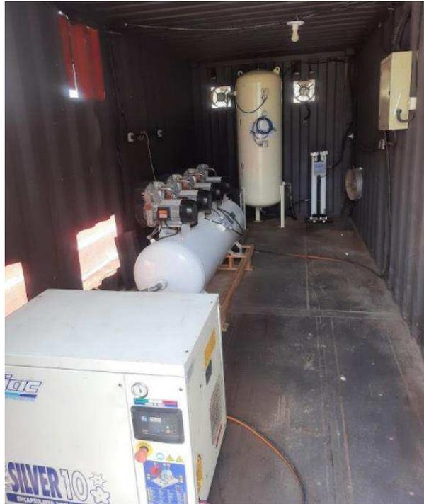
Figura 3.5 – Sistema da central de ar medicinal por compressor (Autor, 2021).
