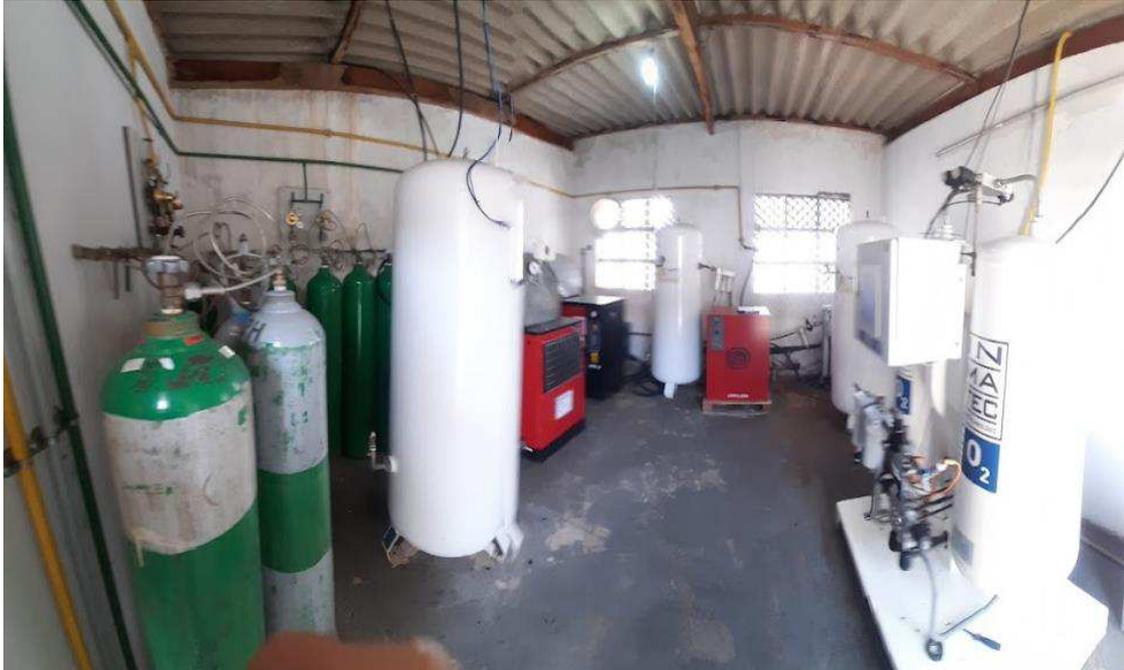
Figura 3.1 - Usina concentradora geradora de O<sub>2</sub> e ar medicinal (Autor, 2021).
