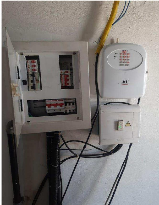
Figura 3.4 – Quadros elétricos e de alarme (Autor, 2021).
