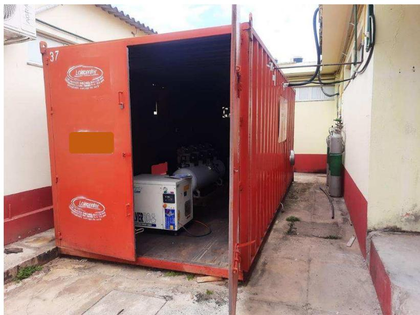
Figura 4.11 – Abrigo do sistema de compressor de ar medicinal da Unidade B (Autor, 2021).
