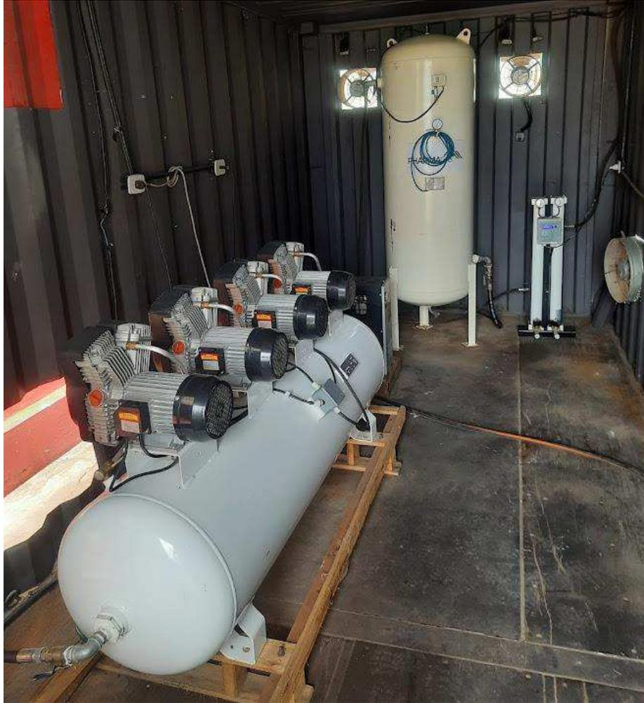
Figura 3.6 – Compressor GR VSF 250, vaso úmido, secador por refrigeração, vaso seco e secador por adsorção (Autor, 2021).
