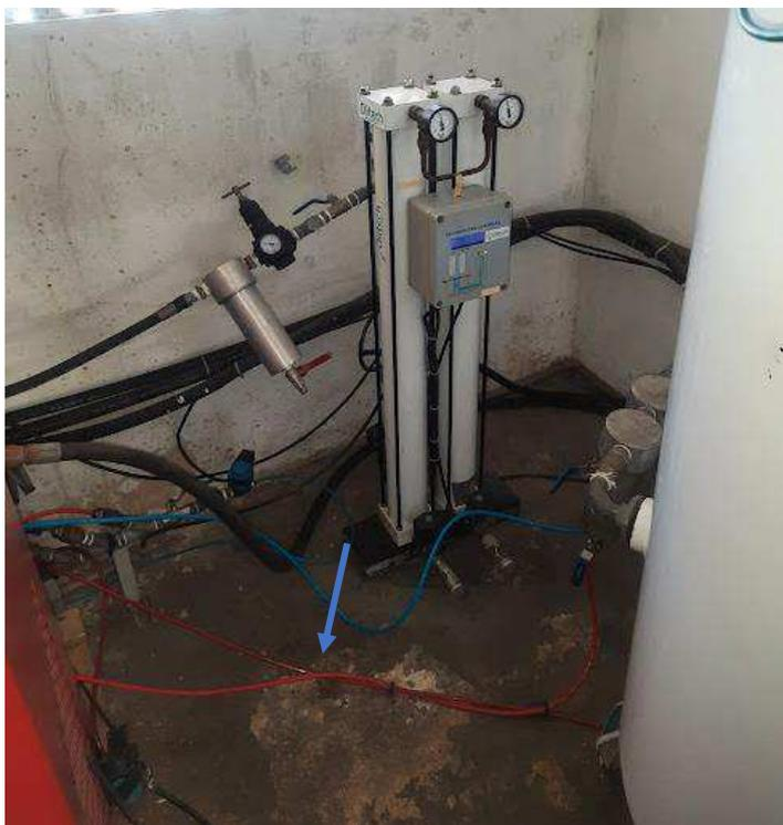
Figura 4.5 - Mangueiras PU substituídas (Autor, 2021).
