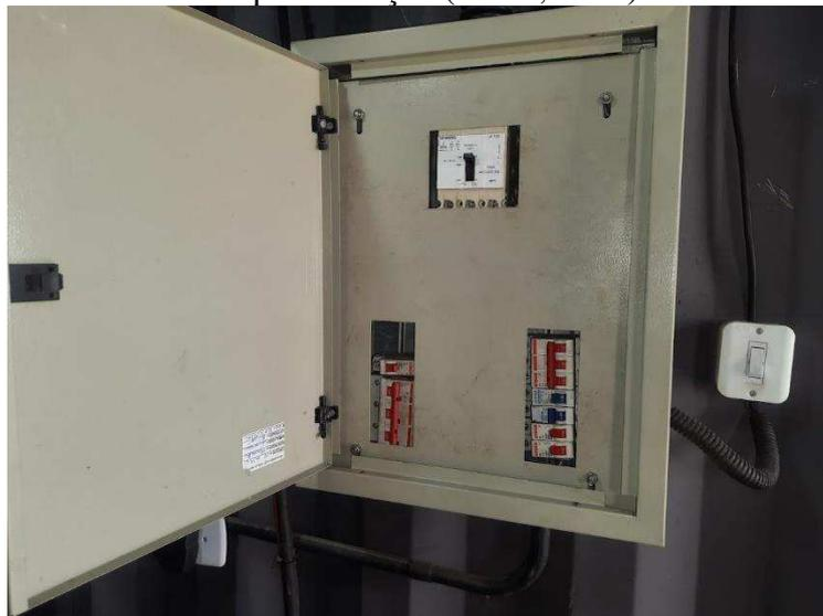
Figura 3.7 – Quadro de comando do sistema de ar medicinal por compressor (Autor, 2021).
