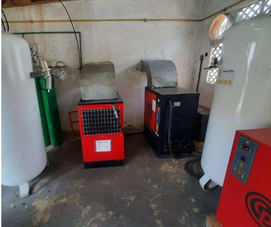
Figura 3.3 - Compressores em paralelo (Autor, 2021).
