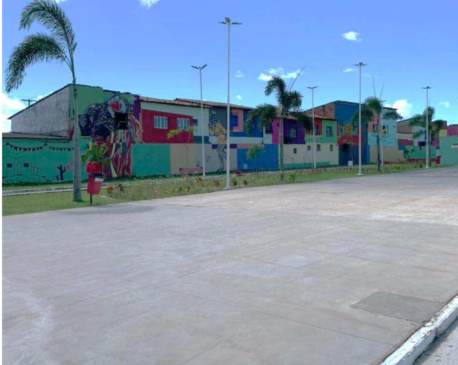
Figura 31- Calçamento em piso cimentício
