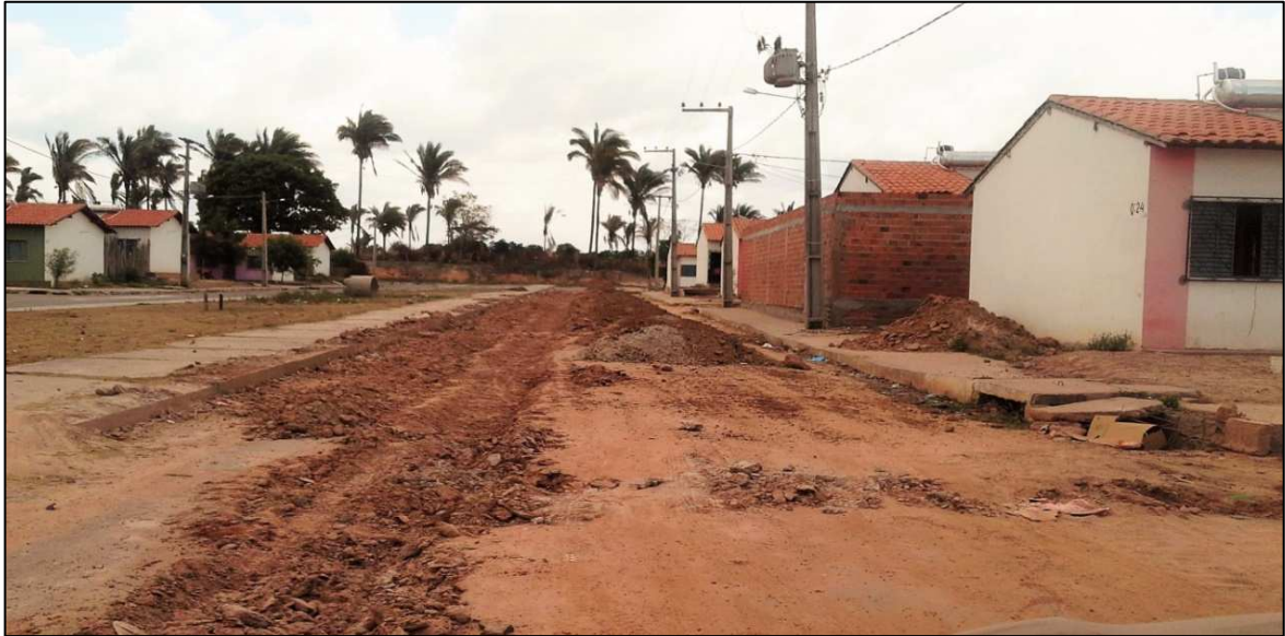
Figura 08: Terra do Sol, bairro planejado (Minha Casa Minha Vida) na cidade de Bacabal – MA (primeiro realiza-se o asfaltamento, depois quebra-se para a encanação do saneamento)
