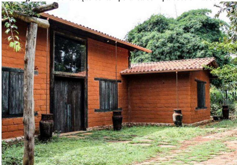
Figura 7 - Construção contemporânea com paredes em adobe.
