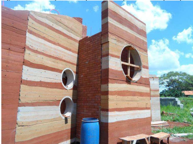
Figura 6 - Construção contemporânea com paredes em taipa de pilão.
