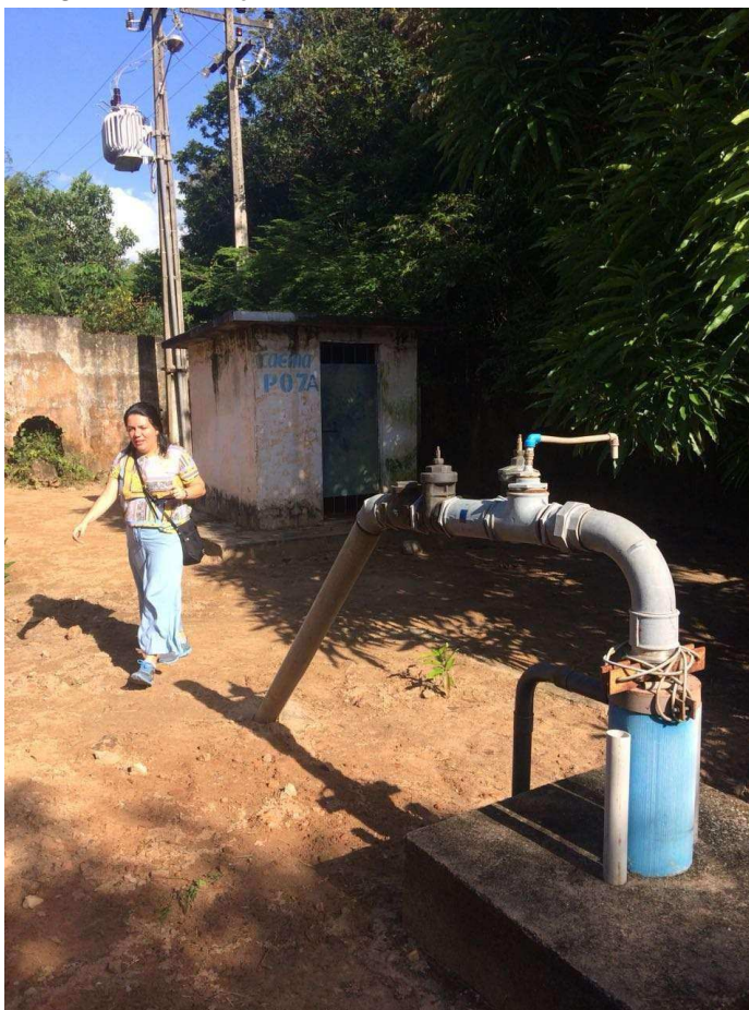
Fotografia 7 - Poço da CAEMA dentro do PEB
