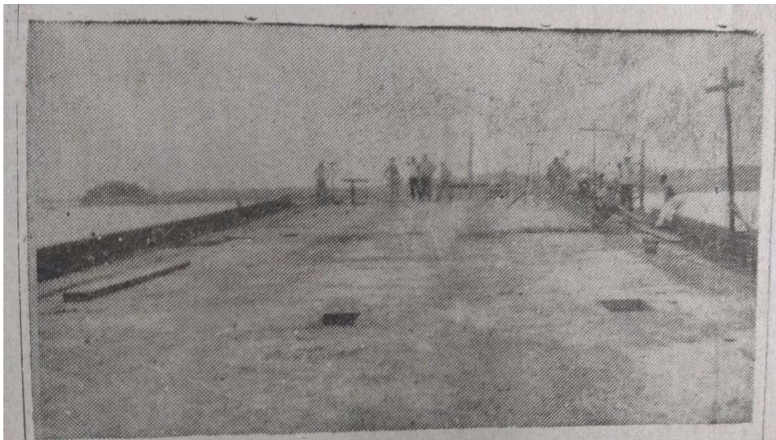
Figura 2: Nessa fotografia podemos observar a ponte Governador José Sarney no momento de sua construção na Véspera do Natal de 1968. Fonte: Jornal O Imparcial. 24/12/1968
