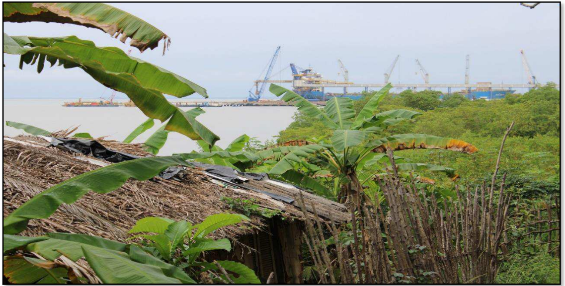
Imagem 3 - A construção do Porto ao lado da Comunidade Camboa dos Frades
