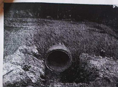
Foto 3 – Construção do Bueiro
