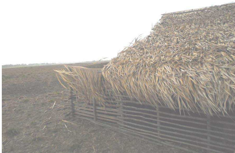
Figura 15 - Retiro composto de telhado de palha, paredes de madeira e chão batido presente nos campos da região da Baixada Maranhense.
