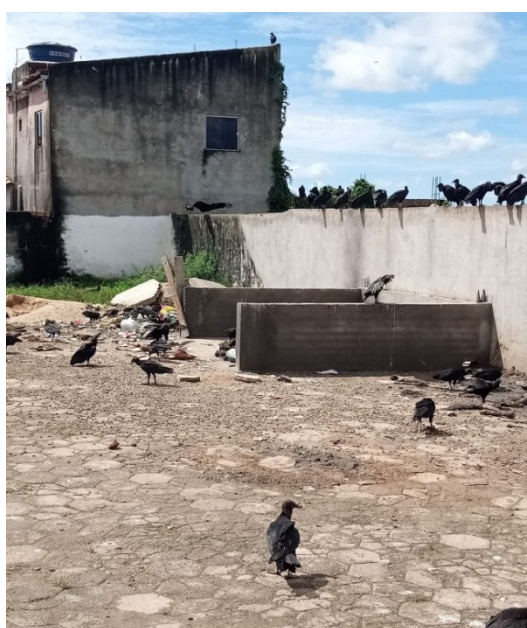
Figura 5 - Estrutura onde são acondicionados os resíduos sólidos
