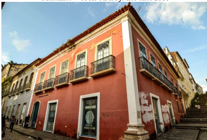
Figura 2 – Fachada externa do Centro de Pesquisa de História Natural e Arqueologia do Maranhão – CPHNAMA já nos anos 2000
