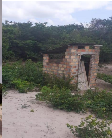
Figura 12 - Banheiro da Escola
