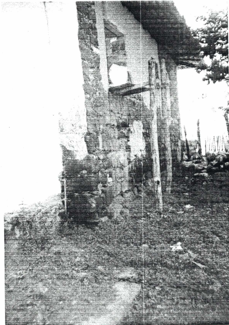
Figura 3 – Casa Grande, onde morava os administradores da usina, na época do senhor Abelardo. É construída de pedras e até pouco tempo o senhor Mano Neto de Aberlado morava aqui
