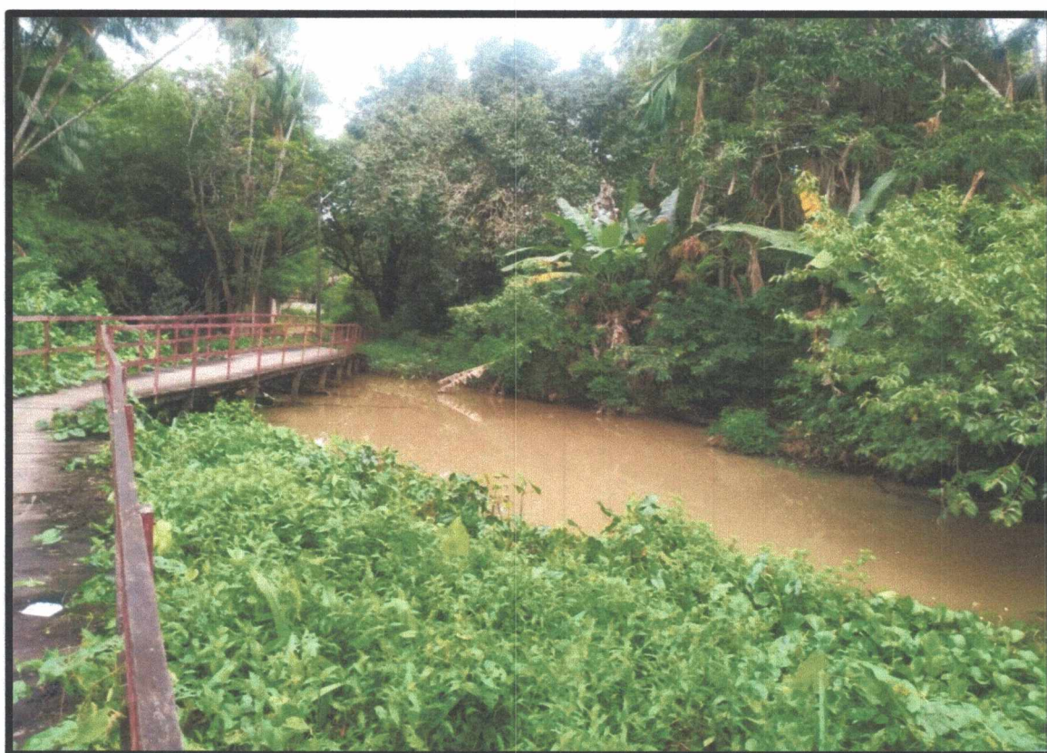
Figura 25 - Canal principal após intensa precipitação
