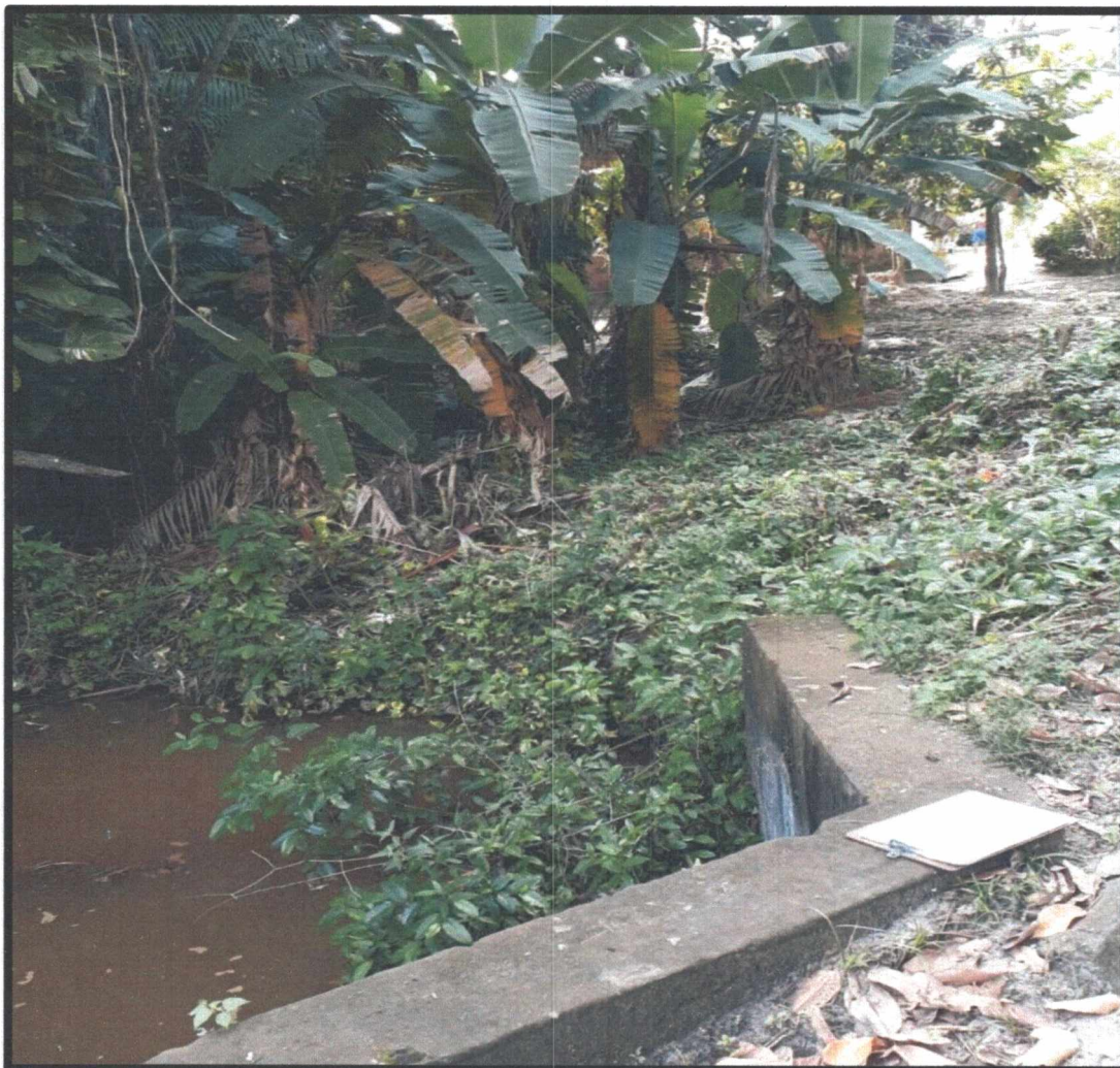
Figura 26 – Canal na localidade Mercês
