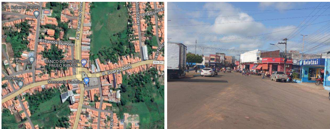
Figura 34 - Ausência de sinalização no cruzamento principal do centro de Paulo Ramos – MA
