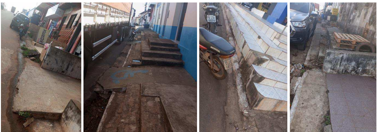
Figura 26 - Calçadas inadequadas para os pedestres
