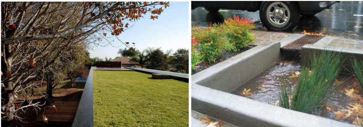
Figura 5 - Estruturas urbanas sustentáveis. À esquerda, Telhado verde e à direita, Jardim de chuva ou biorretenção
