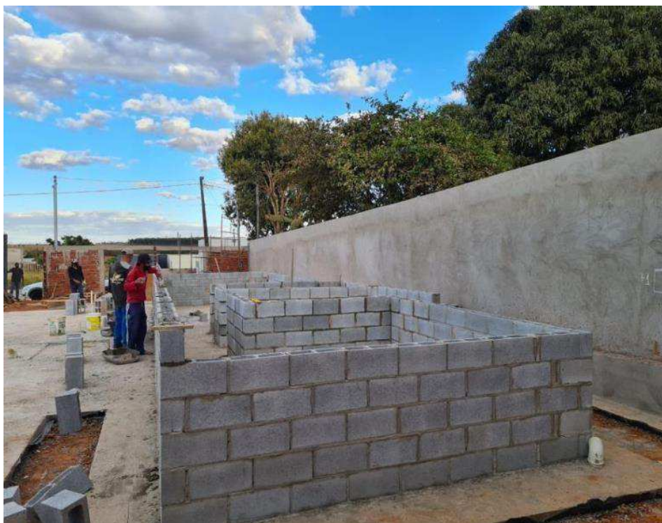
Figura 1 – Elevação em Alvenaria Estrutural com blocos de concreto
