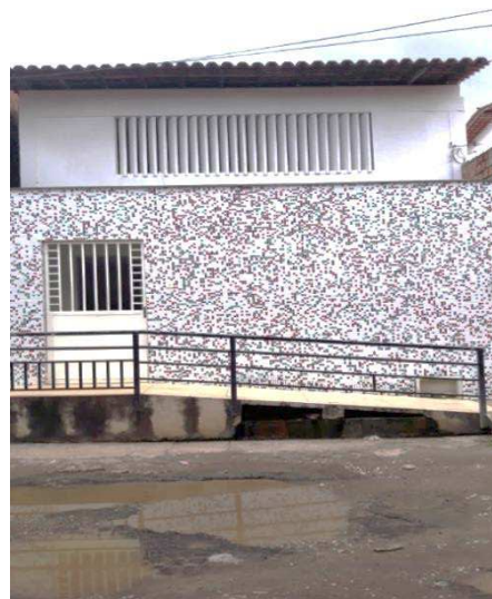
Figura 02: Fachada da creche Catulinho
