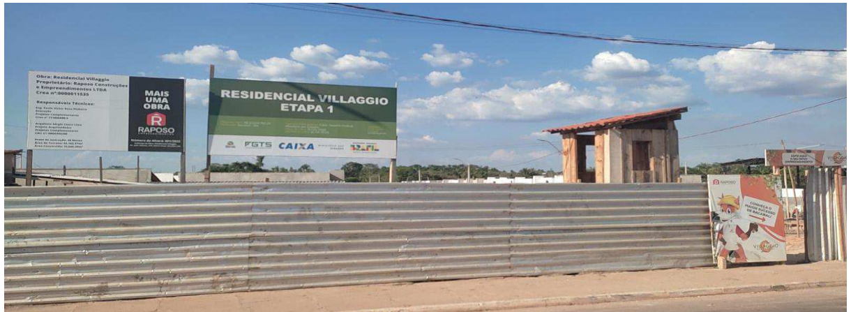
Frente da obra
