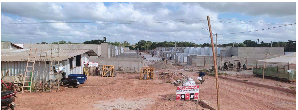
Vista panorâmica da obra – parte 1
